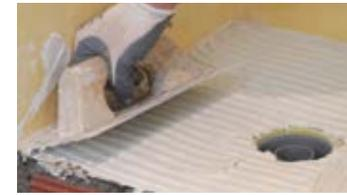
6. Extender cemento cola con la llana de 4 mm sobre la lámina.
