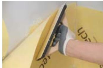
**4.** Revestir la pared con la lámina Revestech DRY50 dejando un solape entre láminas de al menos 5 cm.
