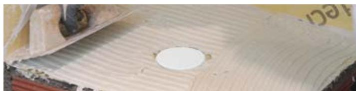
7. Proteger el agujero del sumidero con la pieza tubular blanca (para evitar que se ensucie). Extender el cemento cola sobre la lámina y colocar la cuna del lineal sobre el sumidero.
