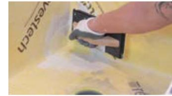
5. Formar las esquinas plegando la lámina. Para un acabado perfecto utilizar las piezas premoldeadas CORNER IN y CORNER OUT.
