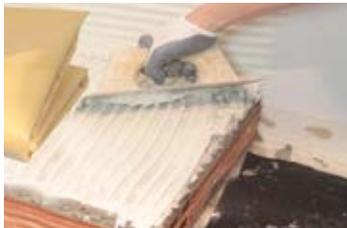
**2.** Extender una capa fina de cemento cola con la llana de 4 mm y extender la lámina sobre el cemento cola.
