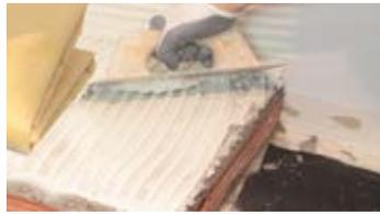
2. Extender una capa fina de cemento cola con la llana de 4 mm y extender la lámina sobre el cemento cola.
