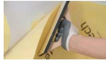
4. Revestir la pared con la lámina Revestech DRY50 dejando un solape entre láminas de al menos 5 cm.
