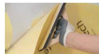
5. Revestir la pared con la lámina Revestech DRY50 dejando un solape entre láminas de al menos 5 cm.
