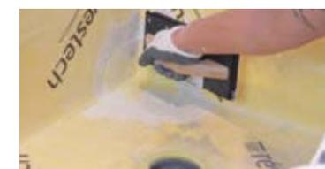
6. Formar las esquinas plegando la lámina. Para un acabado perfecto utilizar las piezas premoldeadas CORNER IN y CORNER OUT.
