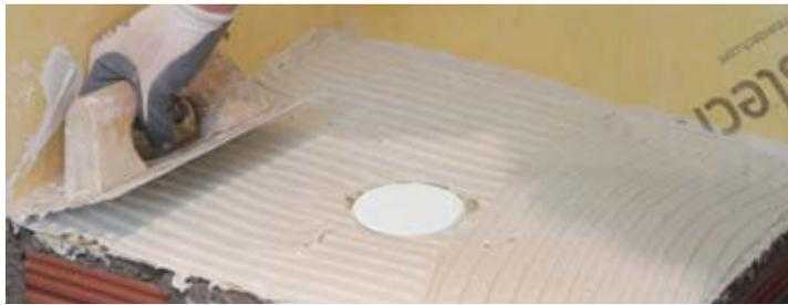
**7.** Proteger el agujero del sumidero con la pieza tubular blanca (para evitar que se ensucie). Extender el cemento cola sobre la lámina y colocar la cuna del lineal sobre el sumidero.
