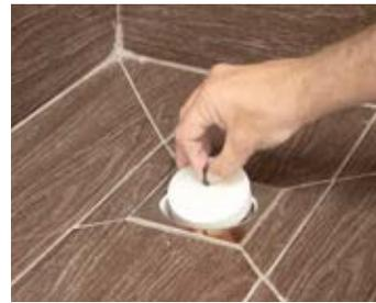
**9.** Colocar el cierre hidráulico (solamente en el caso de que la instalación no esté conectada a un bote sinfónico central) y seguidamente la rejilla. Ya tenemos lista la ducha perfectamente acabada y con garantía total de impermeabilización.
