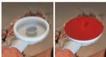
1. Conectar el sumidero a la tubería y formar las pendientes, protegiendo el interior con la tapa de color que después retiraremos.
