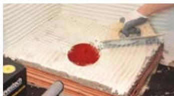
2. Extender una capa fina de cemento cola con la llana de 4 mm.
