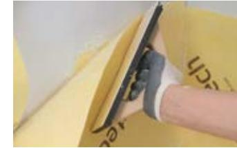
**5.** Revestir la pared con la lámina Revestech DRY50 dejando un solape entre láminas de al menos 5 cm.
