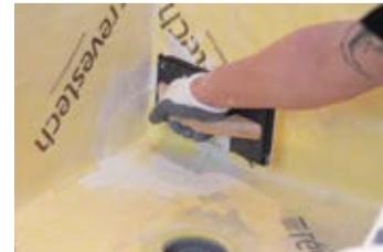
**5.** Formar las esquinas plegando la lámina. Para un acabado perfecto utilizar las piezas premoldeadas CORNER IN y CORNER OUT.
