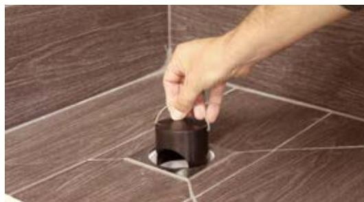
**8.** Colocar el cierre hidráulico (solamente en el caso de que la instalación no esté conectada a un bote sinfónico central) y seguidamente la rejilla. Ya tenemos lista la ducha perfectamente acabada con garantía total de impermeabilización.
