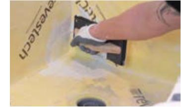
**6.** Formar las esquinas pegando la lámina. Para un acabado perfecto utilizar las piezas premoldeadas CORNER IN y CORNER OUT.
