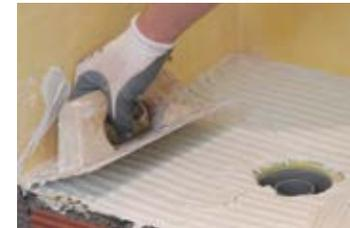
**6.** Extender cemento cola con la llana de 4 mm sobre la lámina.
