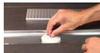
9. Colocar el cierre hidráulico (solamente en el caso de que la instalación no esté conectada a un bote sinfónico central) y seguidamente la rejilla. Ya tenemos lista la ducha perfectamente acabada y con garantía total de impermeabilización.
