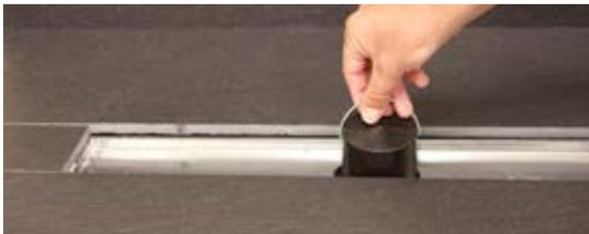
8. Colocar el cierre hidráulico (solamente en el caso de que la instalación no esté conectada a un bote sinfónico central) y seguidamente la rejilla. Ya tenemos lista la ducha perfectamente acabada y con garantía total de impermeabilización.
