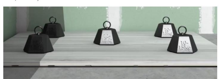
■ 2\_10\_Colocamos peso encima del plato level repartiendo bien las cargas. Muy importante poner el peso siempre sobre la cerámica colocada, nunca directamente encima del plato. Volvemos a comprobar que este todo a nivel (FOTO 2). Esperamos a que esté el cemento cola totalmente fraguado para retirar el peso.
