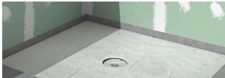
■ 2\_3\_Una vez fraguado el mortero, aplicar sobre el mismo cemento cola clase C2; así como en el reverso del plato (doble encoldado). Instalar.
