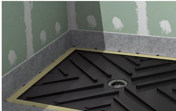
■ 2\_13\_Para evitar manchar el plato, colocar cinta carrocería gruesa en todo el perímetro, desde los topes del plato hacia el interior. Pegar la banda **DRY50 BANDA** sobre los cuatro aleros del plato con adhesivo **REVESTECHFLEX**. Pegar la banda **DRY50 BANDA** a los encuentros con suelos y paredes, usando cemento cola clase C2.
