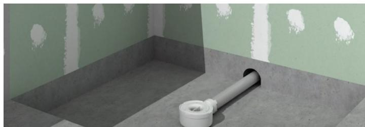
■ 2\_1\_Conectar el sumidero. La tubería deberá tener una pendiente  $\geq 2\%$ . Comprobar la correcta evacuación.
