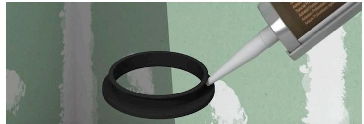
■ 2\_4\_Crear un cordón de adhesivo RevestechFlex en todo el interior de la junta tipo labial.
