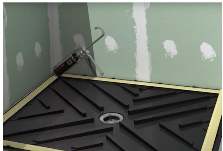
■ 2\_12\_Sellar con **REVESTECHFLEX**, todo el perímetro del plato, en su encuentro con paredes y suelo.
