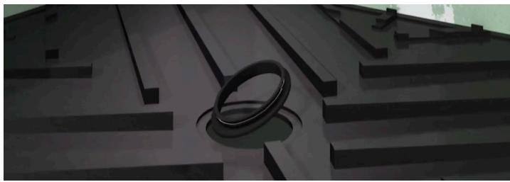
■ 2\_5\_Sellar a la salida de la base Level presionando para repartir el adhesivo. Asegurar que la parte más gruesa de la junta queda hacia abajo. NO ESPERAR A QUE SEQUE PARA EL SIGUIENTE PASO.
