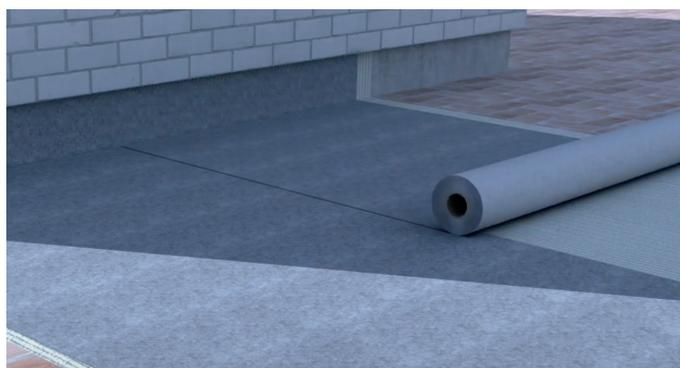
**3.** Instalar las láminas siempre a favor de la pendiente, partiendo del sumidero hacia arriba. Dejar un solape entre láminas de 10 cm.
