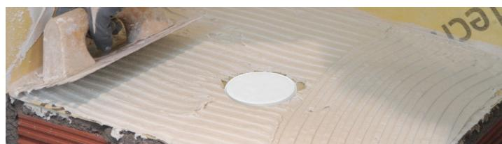
7. Proteger el agujero del sumidero con la pieza tubular blanca (para evitar que se ensucie). Extender el cemento cola sobre la lámina y colocar la cuna del lineal sobre el sumidero.
