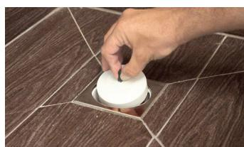
9. Colocar el cierre hidráulico (solamente en el caso de que la instalación no esté conectada a un bote sifónico central) y seguidamente la rejilla. Ya tenemos lista la ducha perfectamente acabada y con garantía total de impermeabilización.
