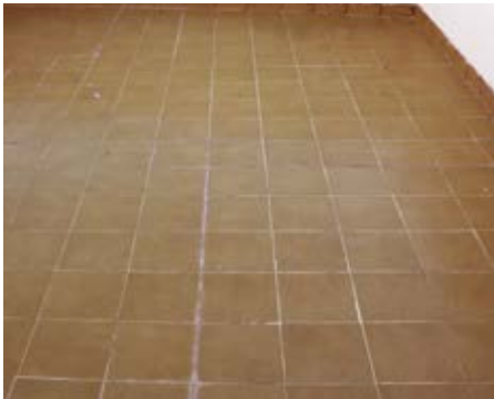
1. Limpiar el soporte. Es conveniente utilizar sosa cáustica para una limpieza más eficaz.
