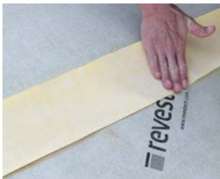
5. Realizar las uniones entre láminas con DRY50 BANDA 13 y adhesivo SEALPLUS* .
