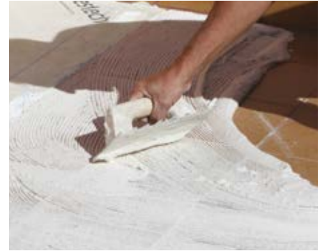
3. Aplicar cemento cola C2 S1/S2 sobre el soporte. Fijar bien la lámina al soporte, asegurándonos de eliminar con la llana todas las posibles bolsas de aire que se puedan generar.
