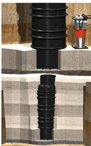
El material de relleno debe ser colocado de forma uniforme alrededor de todos los lados del depósito, hasta alcanzar el nivel del cuello de la boca de hombre.
