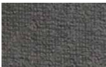
Detalle del estado de la superficie de la banda malla una vez colocada con mortero Traditerm®
