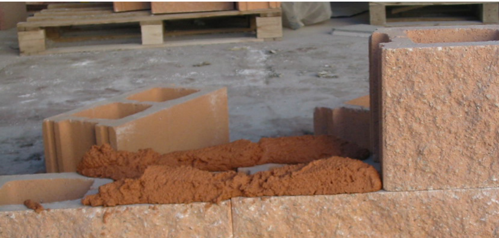
Figura 1. Colocación de bloques con mortero de albañilería
