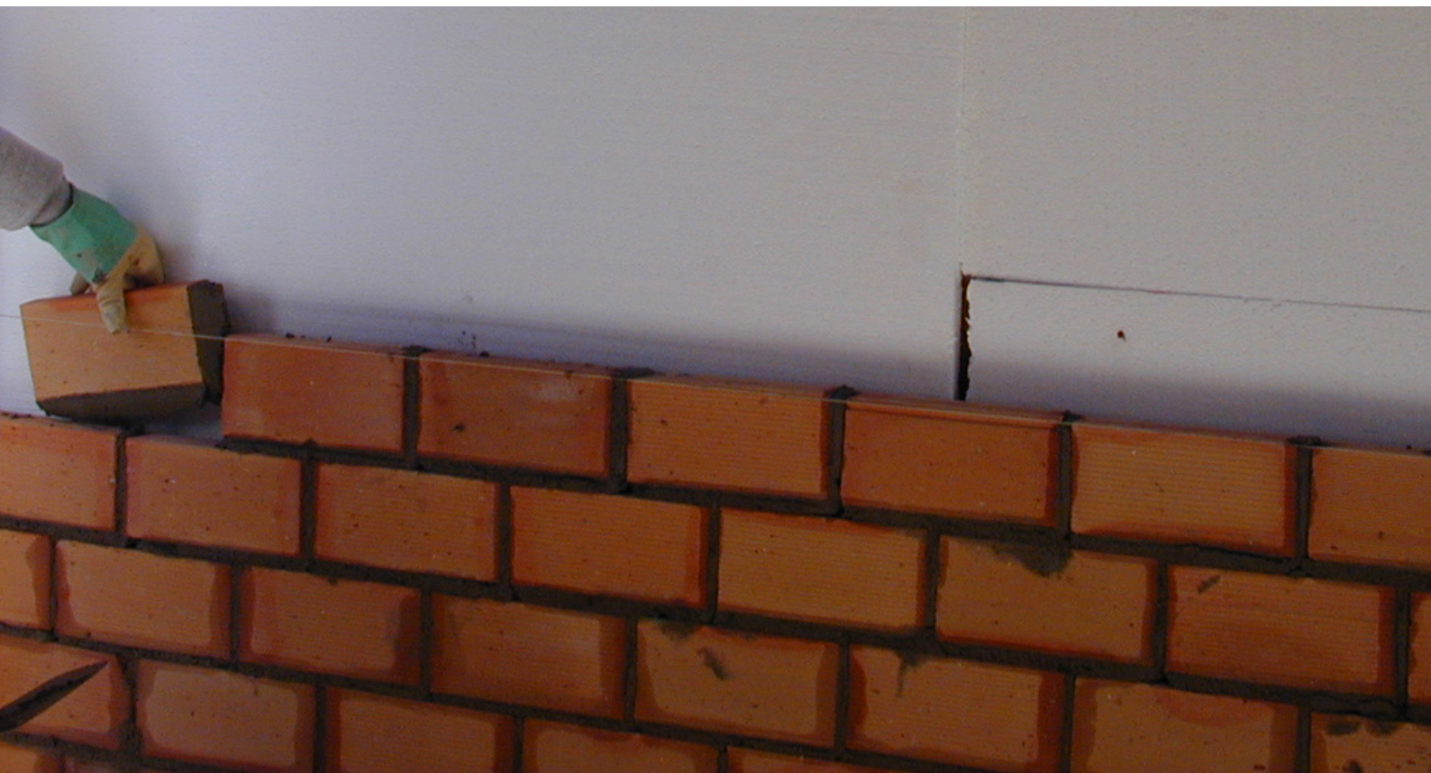
Figura 2. Aplicación del producto
