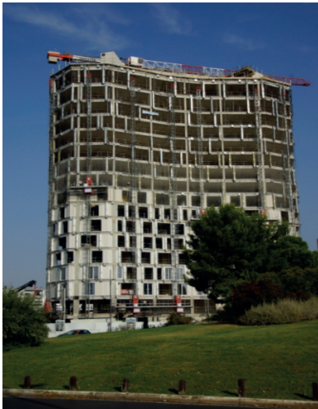
Arbre Blanc. Construcción del sistema de cerramiento SCLIC mientras se construye la estructura.
