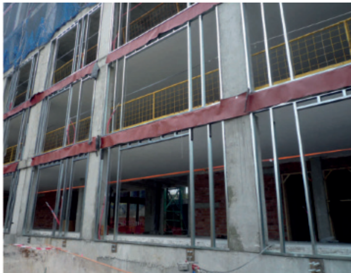
DCW2 y DCW4 Instalación de la estructura de soporte.
