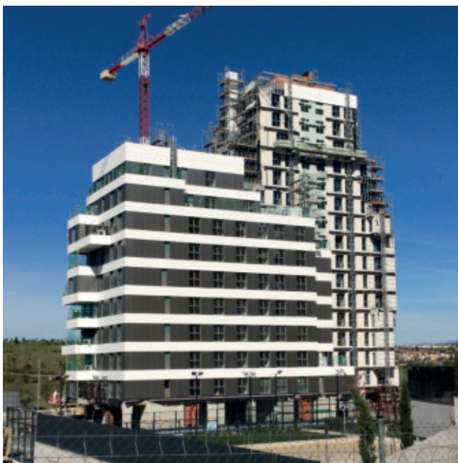
Edificio de viviendas Valdebebas. Fachada con sistema SCLIC y acabado EQUITONE.
