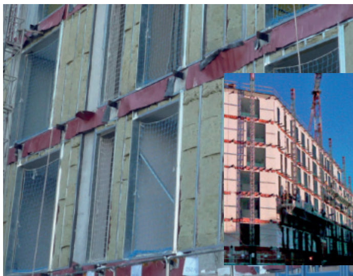
DCW2 y DCW4 Instalación de la lana de aislamiento.
