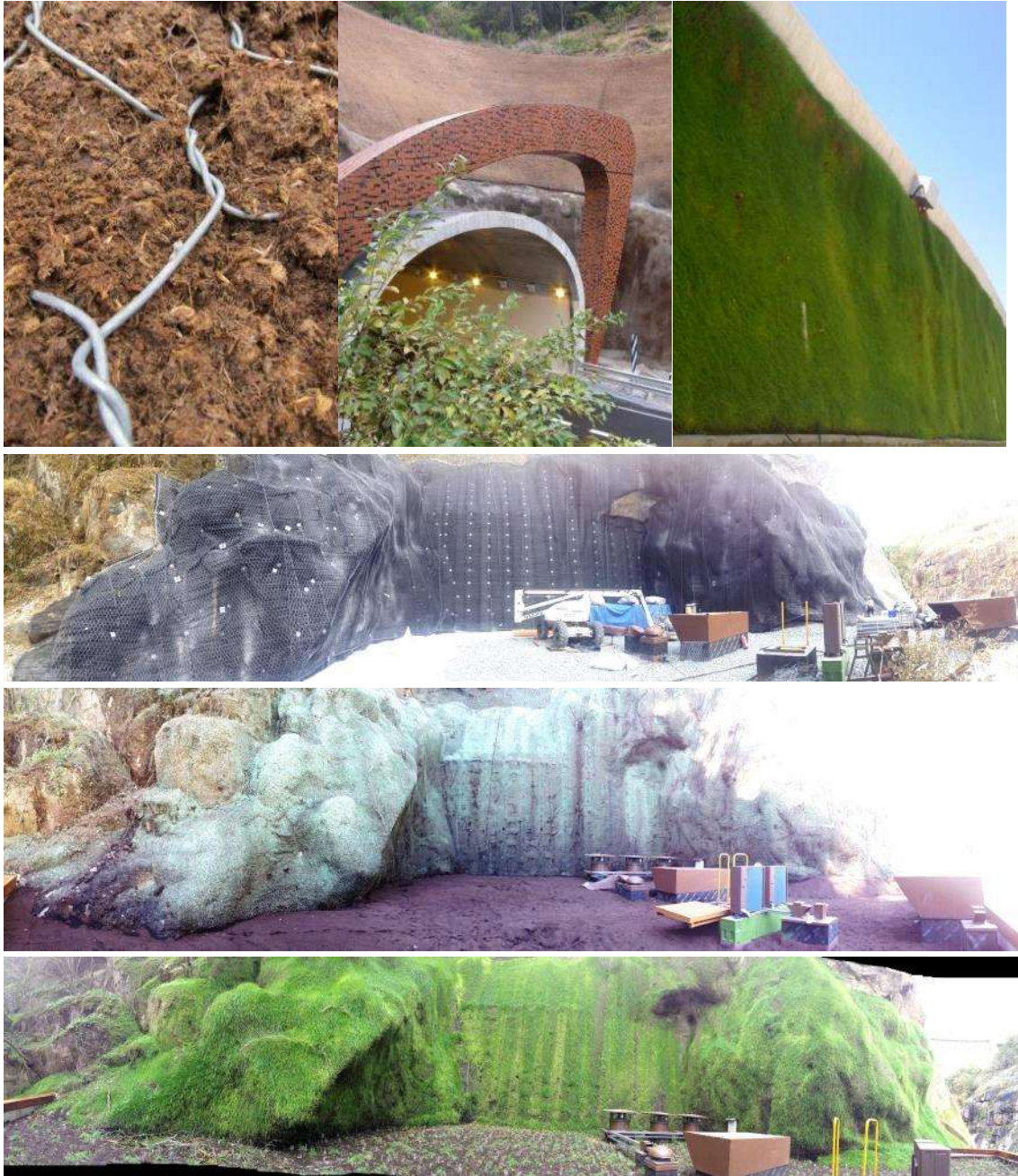
Figura 6_Ejemplos de instalaciones Tecroc Verde_Belesar_Gas Natural Fenosa
