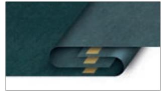
Aplique presión para unir las dos tiras. Puede deslizar una tabla de madera de 30 cm de ancho por debajo del sellado como superficie de apoyo. Mueva la tabla mientras une las dos tiras.
