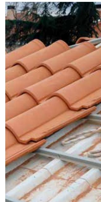
Perfilería metálica, omegas.
