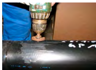
13. Repasar los orificios con una broca.
