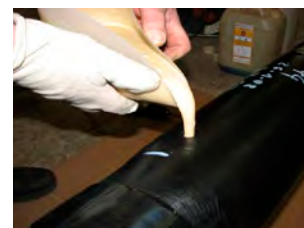
12. Introducir la mezcla de poliuretano por los orificios en la camisa.
