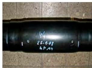
11. Realizar los dos orificios para rellenar con la espuma.
