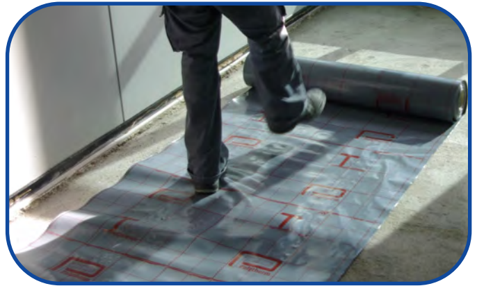
2.- Colocación hoja PE. Debe ser doble y que se eleve 5cm por la pared.
