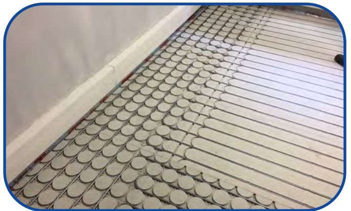
6.- Hacer la prueba de presión. Una vez hecha verter el mortero auto-nivelante.
