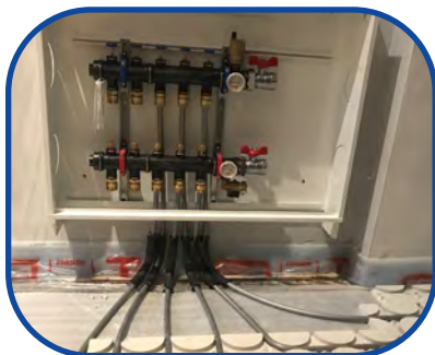
5.- Colocación tubo de los distintos circuitos.
