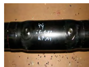
16. Colocar los parches sobre los tapones definitivos con ayuda de un soplete.
