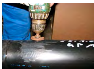
13. Reparar los orificios con una broca.
