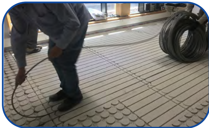
5.- Colocación tubo de los distintos circuitos.
