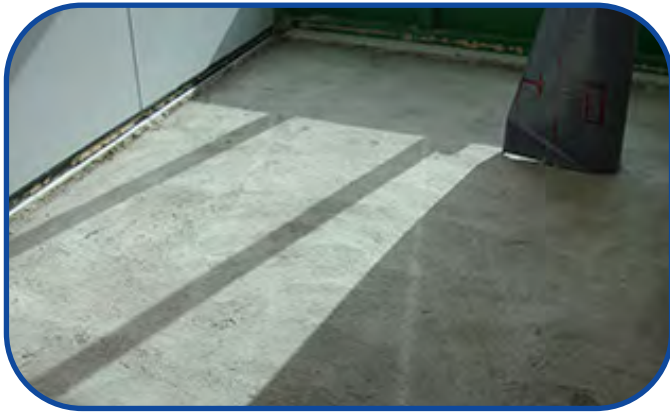
1.- Preparación de la solera. La superficie debe estar limpia y plana.
