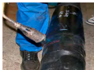
10. Calentar con la antorcha hasta que quede totalmente soldado.
