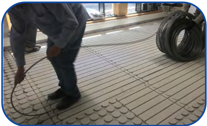
5.- Colocación tubo de los distintos circuitos.
