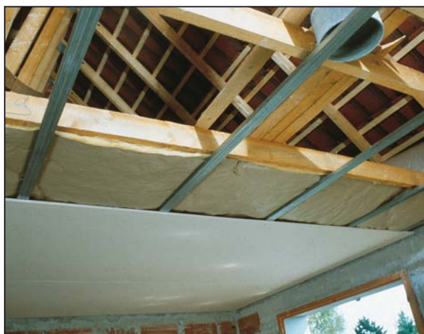
Ossature métallique Stil® F 530 sous solives bois.
