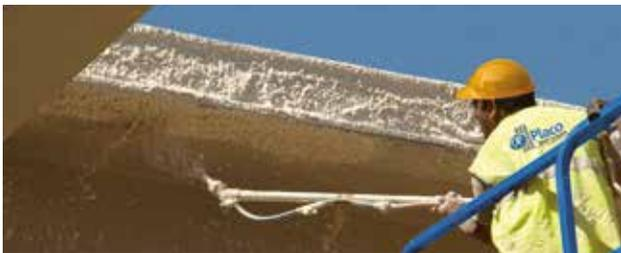
**1** Proyectar sobre el soporte mediante máquina, ajustando el caudal para obtener una masa con las características deseables.
