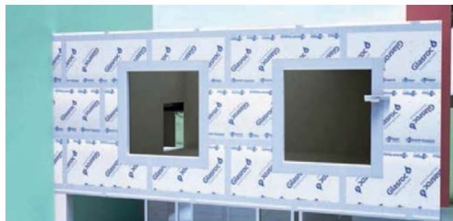
Figura 6.3: Placa exterior Glasroc® X y su tratamiento de juntas.
