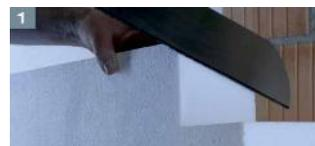
**2** Con la ayuda de una sierra o máquina de hilo caliente, cortar las piezas al espesor requerido.
