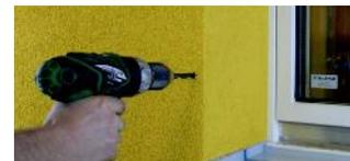
2 Atornille el elemento de fachada al PRISMA. La profundidad de atornillado debe ser al menos 30 mm de modo que la sujeción recoja todo el espesor de la pletina de aluminio embebida.
