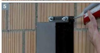
**6** Ejecutar la instalación del aislante del sate alrededor de la pieza sin dejar huecos.
