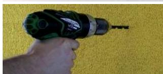
**7** Atornillar el elemento de fachada al CUBO PU-ACERO FIX. La profundidad de atornillado debe ser al menos de 35 mm, de modo que la sujeción recoja todo el espesor de la pletina de aluminio embebida.
