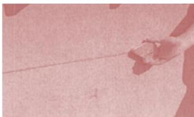
2 Con la ayuda de la herramienta adecuada, ir perforando el aislante hasta conseguir la forma (trapezoidal o triangular) y profundidad necesaria para encajar la malla de fibra de vidrio que se precisa.
