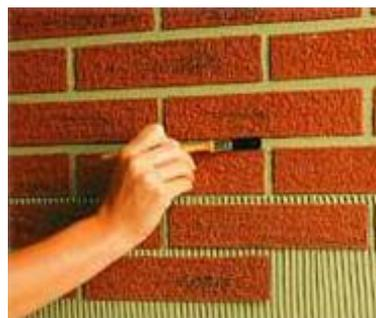
5 Las piezas o plaquetas flexibles se pueden cortar fácilmente con tijeras, cúter o cuchillo. 6 Existe el formato de pieza de esquina para dar continuidad al acabado.
