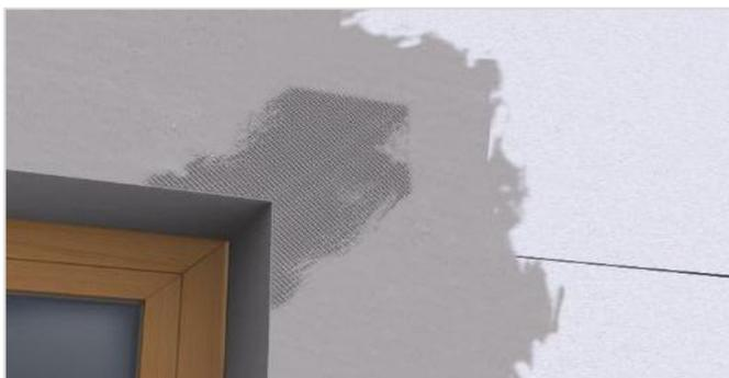
2 En su defecto se puede utilizar un trozo de malla RHONAMESH T-150.
