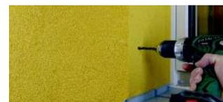
2 Atornille el elemento de fachada al PRISMA PU-RESINA FIX. La profundidad de atornillado debe ser al menos 30 mm de modo que la sujeción recoja todo el espesor de la pletina de aluminio embebida.
