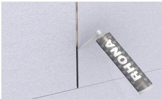
**13** Prestar especial atención a los vértices de puertas y ventanas ya que en ellas se generan muchos esfuerzos. En estos puntos hay que colocar paneles completos, recortándolos para que se ajusten alrededor de las aberturas y evitar la creación de fisuras y grietas. No se debe hacer coincidir las juntas de los paneles con dichas esquinas.
