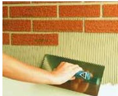
3 Colocar y presionar las losetas flexibles sobre el adhesivo en hiladas horizontales. No dejar juntas horizontales y verticales mayores ni menores a 10-12mm para no aumentar la cantidad de losetas por m<sup>2</sup>. La superficie de contacto debe ser total.
