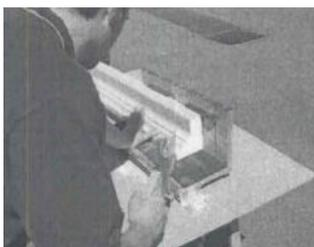
· **4** Para el pegado de las molduras se debe utilizar el método del doble encolado: aplicar RHONA S-400, en cordones de no más de 1cm de separación entre ellos, sobre el soporte (capa base armada) en todo el ámbito marcado para la posición de la moldura y a continuación, **5** sobre toda la superficie del dorso de la misma.
