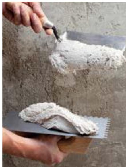
Enlucido de exterior a base de cemento, áridos de granulometría es-reparación de aristas, reperfilado de labios de junta, etc. en fachadas, para el revestimiento de elementos estructurales, regularización de superficies de hormigón y para el retapado de huecos y cavidades en soportes cementosos.
