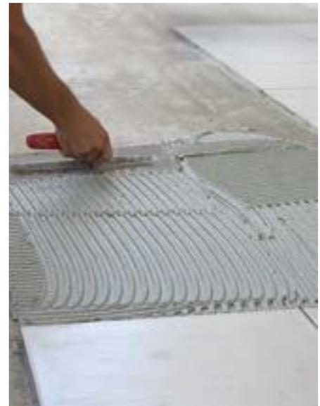
Adhesivo cementoso mejorado con deslizamiento reducido, tiempo abierto ampliado y deformable de clasificación C2TES1 destinado para el pegado de azulejos sobre superficies de albañilería.
