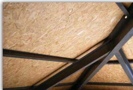
Acabado interior en OSB 3 de 10 mm
