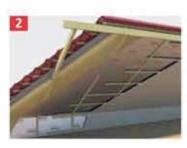
Fijar mecánicamente la lámina barrera de vapor ONDUTISS® BARRIER REFLEX a la cubierta. Evitar cualquier daño de la lámina. Utilice ONDUFILM o una cinta de doble cara para un sellado hermético de todas las juntas. De acuerdo con el sistema constructivo de la cubierta, fijar ONDUTISS® BARRIER REFLEX en posición mediante la sujección de los paneles interiores de cubierta o fijando un enrastrelado sobre la membrana protegiendo las líneas de fijación de esta.
