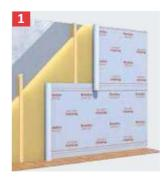
Extienda la lámina a prueba de vapor ONDUTISS® BARRIER en paralelo al suelo siempre con el lado impreso hacia usted. El solape entre láminas se indica mediante líneas o estampado de logotipo. Fije las bandas ONDUTISS® BARRIER directamente al marco con una grapadora. Utilice cinta selladora ONDUTISS® UNO para sellar todas las juntas y conexiones.
