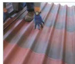
Las **partes planas** de las placas permiten **caminar y arrodillarse** de una forma segura y más confortable
