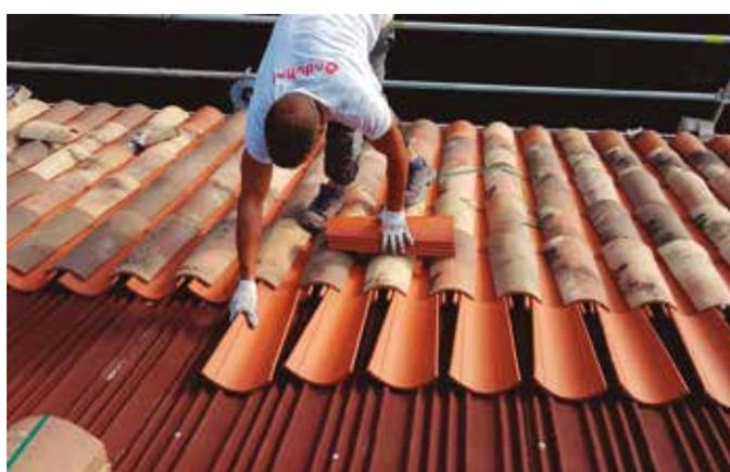
Las placas Onduline Bajo Teja DRS ofrecen una plantilla que facilitan la colocación de las tejas curvas. No es necesario calzarlas y **la cubierta se realiza en seco**, con gancho y espuma, evitando el uso de mortero.
