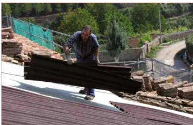
Las placas Onduline Bajo Teja DRS pesan solamente 3Kg/m<sup>2</sup>, factor muy importante en rehabilitación. Se **evita la sobrecarga en estructuras** tanto antiguas como nuevas, permitiendo trabajar con mayor seguridad.
