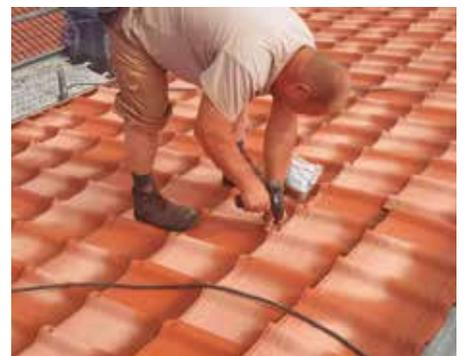
ONDUVILLA® se fija al soporte con tornillos universales de cabeza plástica y arandela. Estos se atornillan a través de la parte alta de la onda, garantizando una **fijación segura** y la estanqueidad del sistema.
