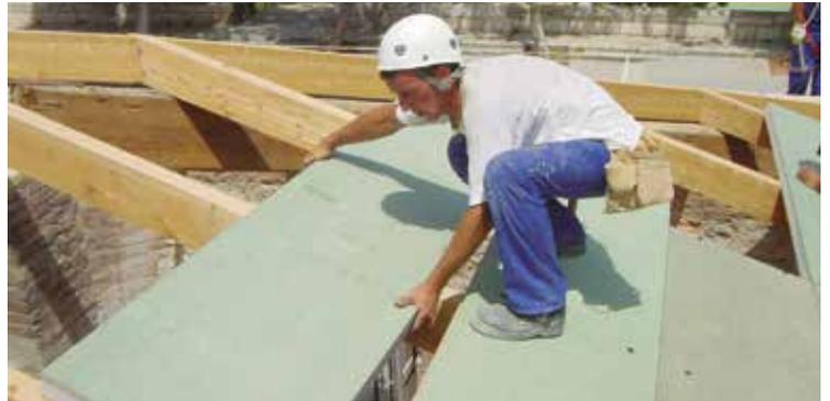
La ligereza del panel sándwich ONDUTHERM, permite trabajar de forma rápida y segura. Además con ONDUTHERM **se evitan** los tiempos de espera por **fraguados y coordinación de gremios**.
