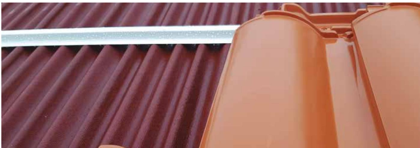
■ **Obligación de impermeabilizar** el soporte por debajo de unas pendientes mínimas, en función del tipo de teja utilizada.
