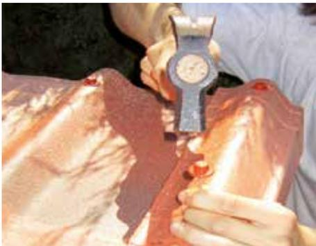
Posicionar y clavar el remate lateral ONDUVILLA® de **alero a cumbre**. Solapar el remate lateral haciendo coincidir las marcas de solape.
