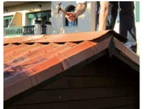
Colocar las piezas de cumbre ONDUVILLA® solapándolas un mínimo de 10 cm y fijándolas a través de la **parte alta de las ondas**.
