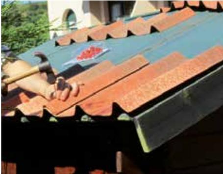
Colocar la primera fila de tejas solapando lateralmente y fijando a través de la **parte alta de las ondas**. Dejar sin fijar las ondas de ambos extremos. El **vuelo máximo** de ONDUVILLA® sobre el alero será de 5 cm.
