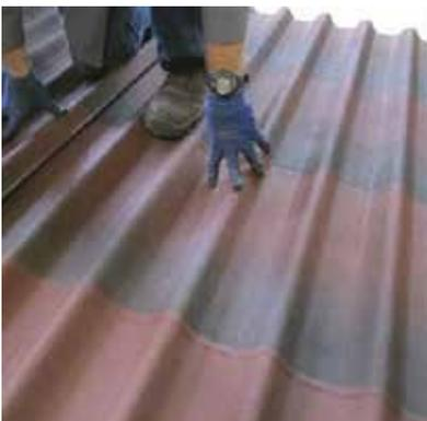
Las **partes planas** de las placas permiten **caminar y arrodillarse** de una forma segura y más confortable.
