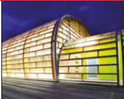
Las placas **ONDUCLAIR® PC** están constituidas por resina termo-plástica de policarbonato.
