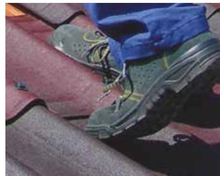
Gracias a su formato ondaplano, ONDUVILLA® permite ágilmente sobre esta y sin dañar las tejas, apoyando el pie en la **parte plana** de las mismas.
