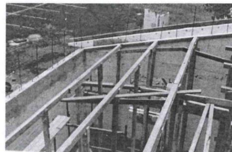
El siguiente paso es doblar todas y cada una de las varillas que se dejaron ahogadas para tener continuidad en el acero. Se deben de doblar a una distancia de máximo de 1" de los **“Paneles de Entrepiso Aislante MAKROS NOVIDESA”** para que tenga recubrimiento el acero.
