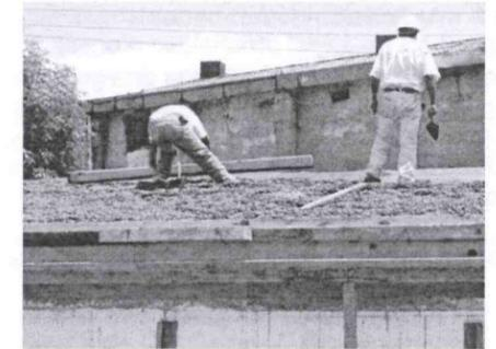
Es necesario recordar que a pesar de ser una losa aligerada el tiempo de fraguado máximo del concreto es de 28 días, por lo que se deben de tomar las precauciones correspondientes para retirar la cimbra de los "Paneles de Entrepiso Aislante MAKROS NOVIDESA"
