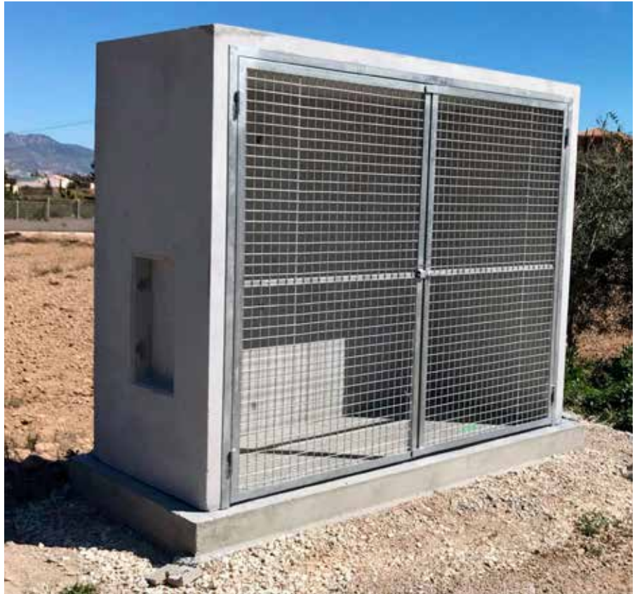
Modernización de regadíos de Pliego (Región de Murcia).
