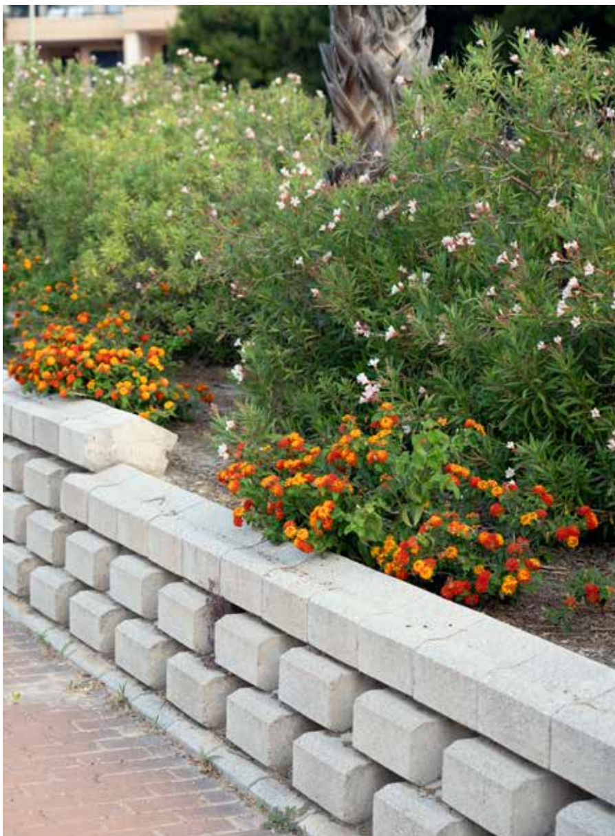
Muro ribazo en hiladas espaciadas. Hospital (Radioterapia) San Juan de Alicante (Comunidad Valenciana).
