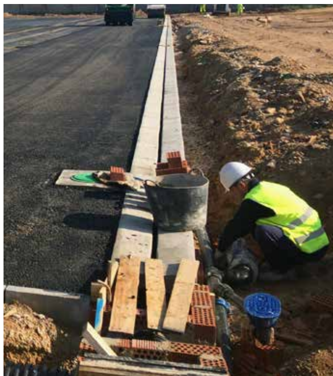
Obras de canalización en el campo municipal de fútbol de Pobla de Vallbona, Valencia (Comunidad Valenciana).
