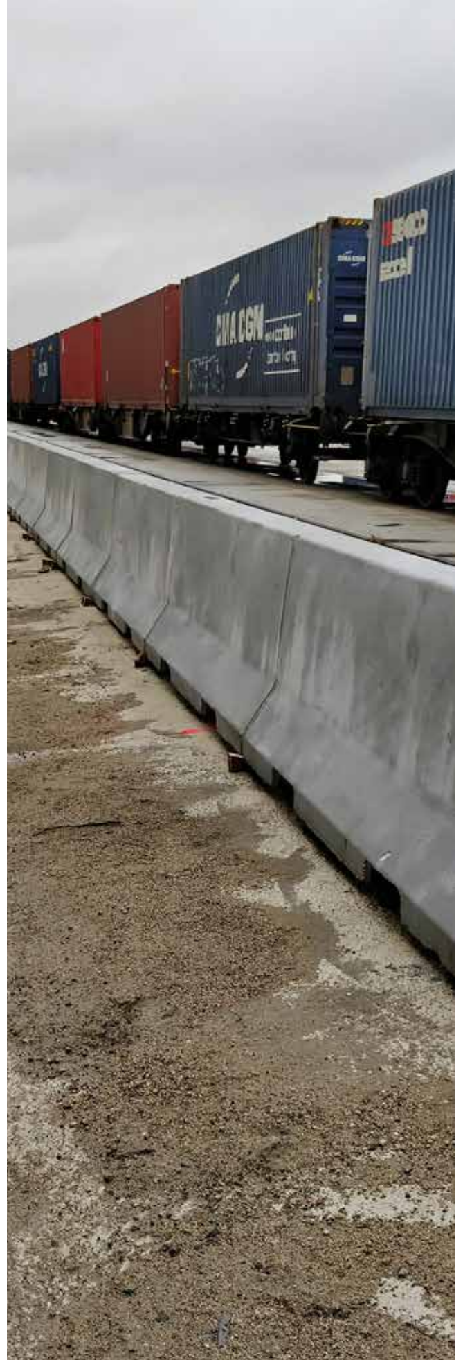
Barreras de contención en Puerto de Sevilla (Andalucía).
