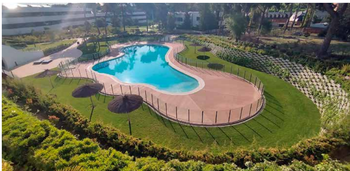
Ambas fotografías. Muro Alpenstein vegetalizado en urbanización Prado Pozuelo. Pozuelo de Alarcón (Comunidad de Madrid).
