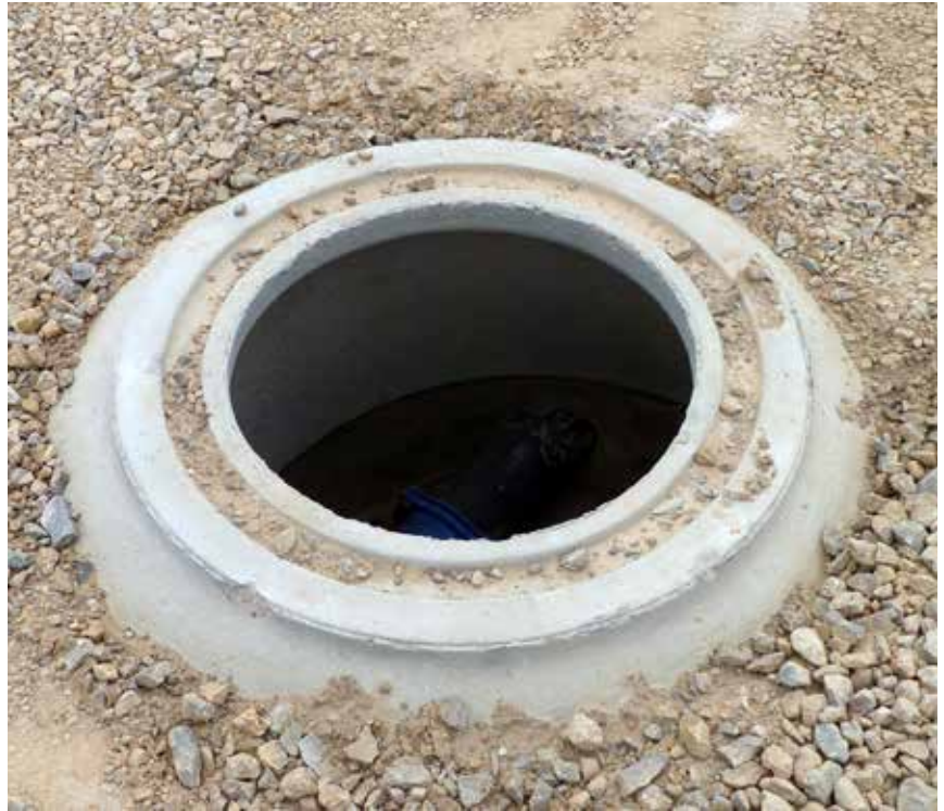
Cono de alcantarillado.
