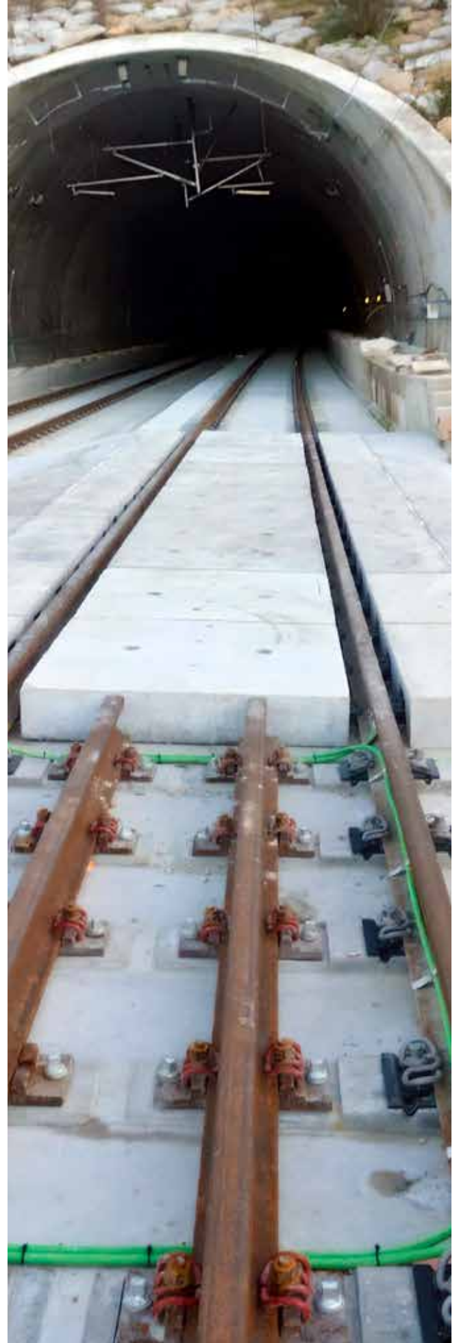
Paso bivalve en acceso a túnel línea Campobeceros-Taboadela (Asturias).
