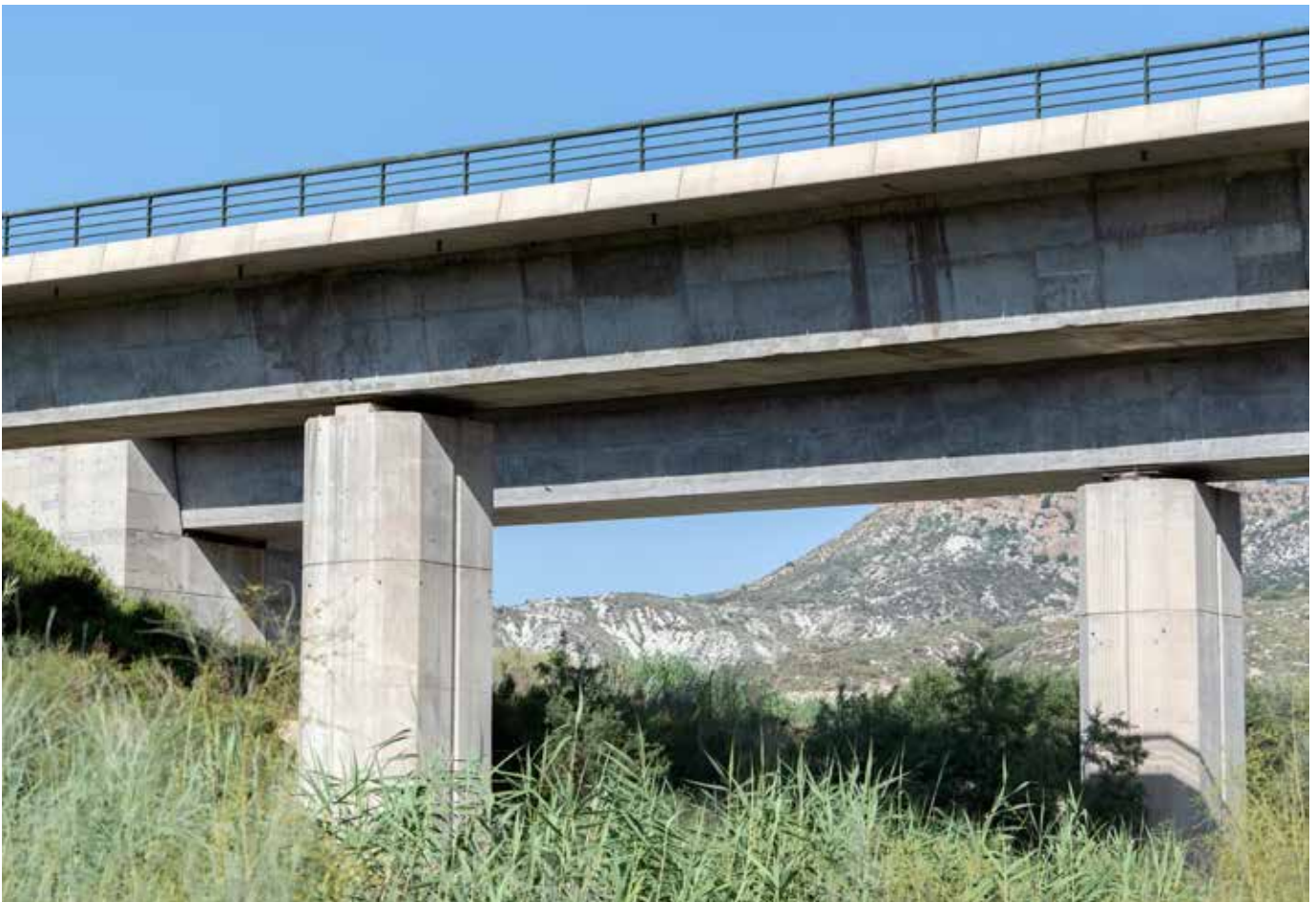
Detalle impostas en viaducto AVE tramo Los Gallardos, Almería (Andalucía).
