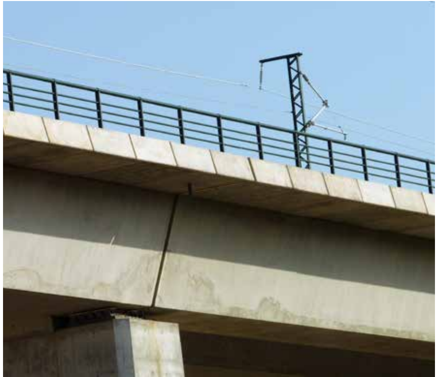
Impostas en viaducto AVE tramo Totana-Lorca (Región de Murcia). Doble página siguiente: Viaducto AVE Los Gallardos, Almería (Andalucía).
