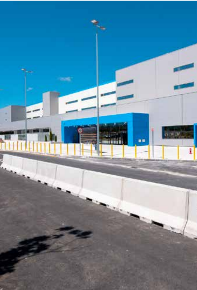
Barreras de contención en nuevo almacén de Amazon. Siero (Asturias).
