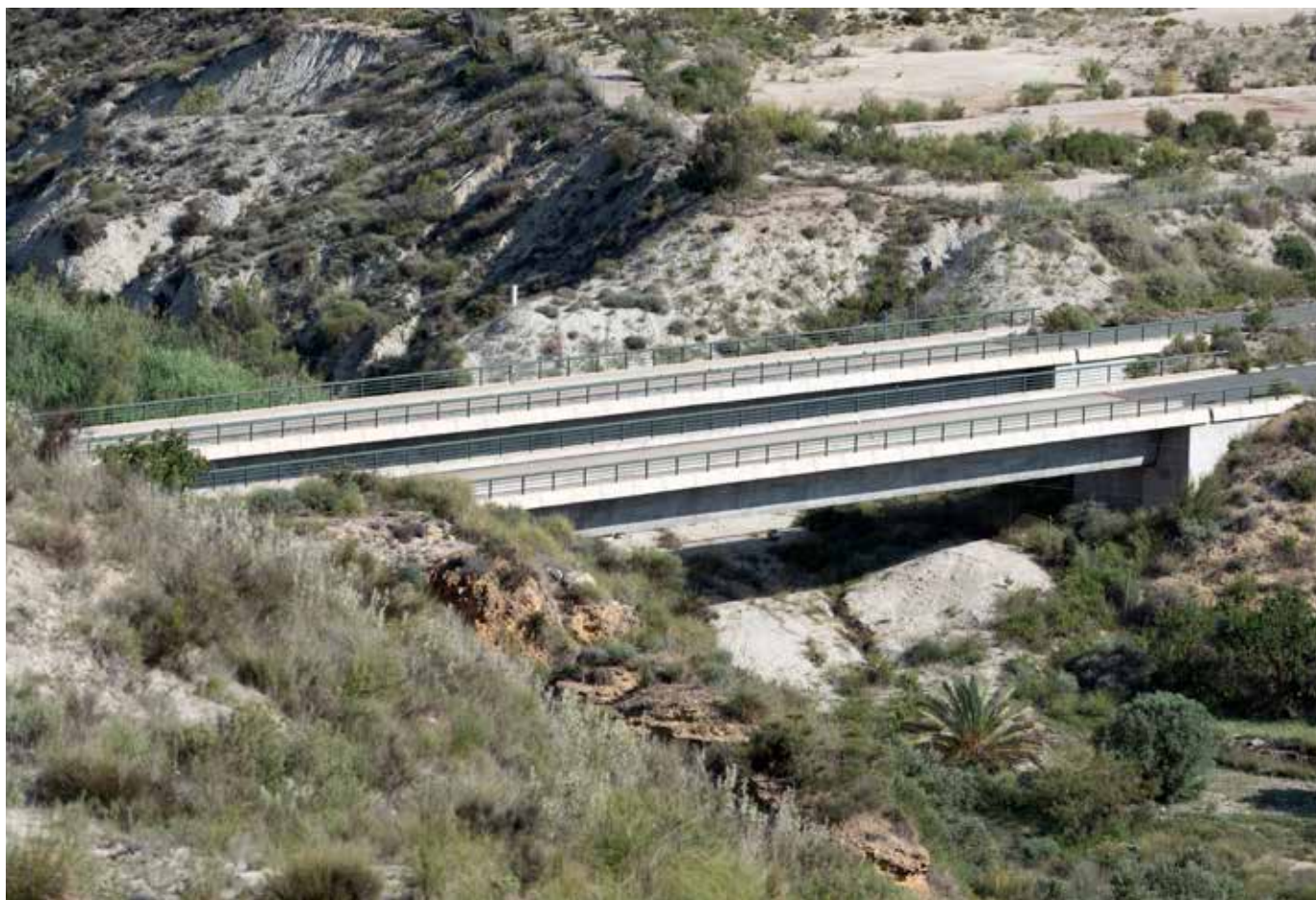
Viaducto para el AVE sobre rambla en los Gallardos, Almería (Andalucía).
