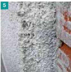
5 Para realizar o revestimento de acabamento, esperar que o **PROPAM TERM 50** seque (1 dia por cm de espessura).
