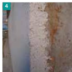
4 De aplicação contínua, permite espessuras compreendidas entre os 20 e os 80 mm e adapta-se perfeitamente a qualquer geometria de fachada, proporcionando um isolamento térmico sólido, não descontínuo, com diferentes acabamentos e excelentes resistências mecânicas ao impacto e ao puncionamento.
