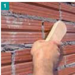
O substrato deverá ser estável e estar isento de poeira, pintura, óleo, etc. Não aplicar sobre restos de gesso. Novas midas: são soportes adequados de tijolo cerâmico, in situ concreto ou pré-fabricada, bloco de concreto e argamassa de rebocos de cimento. Antiga: eles precisam de tratamento específico.
