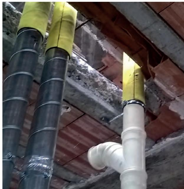
Todos los cambios de dirección se realizarán mediante accesorios para evitar la manipulación de la tubería aplicando fuentes de calor.
