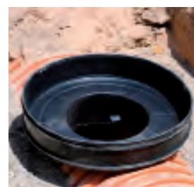
INSTALACIÓN DEL CUERPO CON BASE DE REGISTRO.
