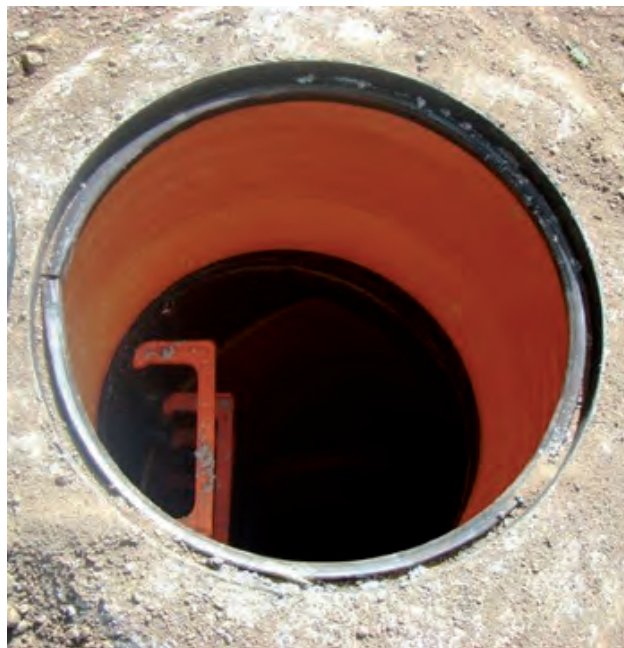
CORONACIÓN DEL POZO.
