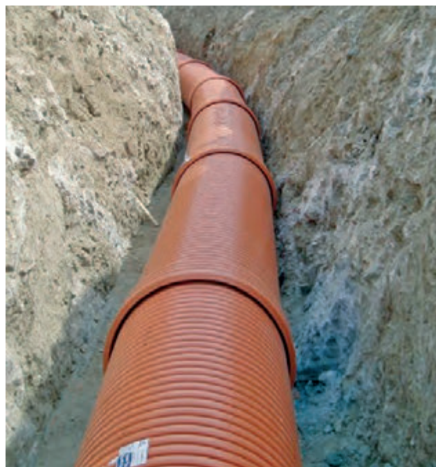
TUBERÍA SANECOR® DE 1200 mm CON DESVIACIÓN ANGULAR.
