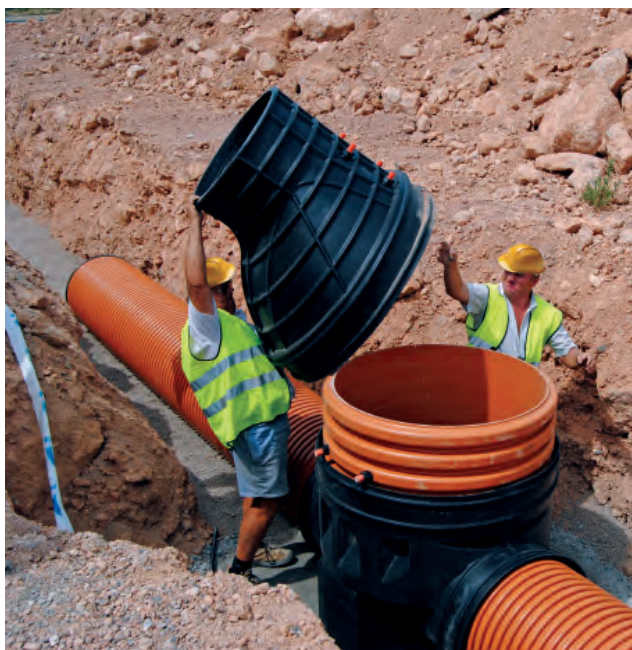
INSTALACIÓN DE PIEZA ENTRONQUE DE PASO TOTAL.
