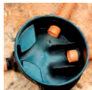
CONEXIÓN CON ELEMENTOS PLÁSTICOS PREFABRICADOS.
