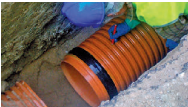
CONEXIÓN MANUAL DE TUBERÍA CORRUGADA.
