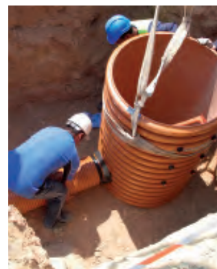
INSTALACIÓN DE TUBERÍAS AL CUERPO DEL POZO.
