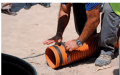
SECUENCIA DE MONTAJE DE PIEZA “DIADEMA” PARA EL TOPE DE LAS ACOMETIDAS SANECOR®.
