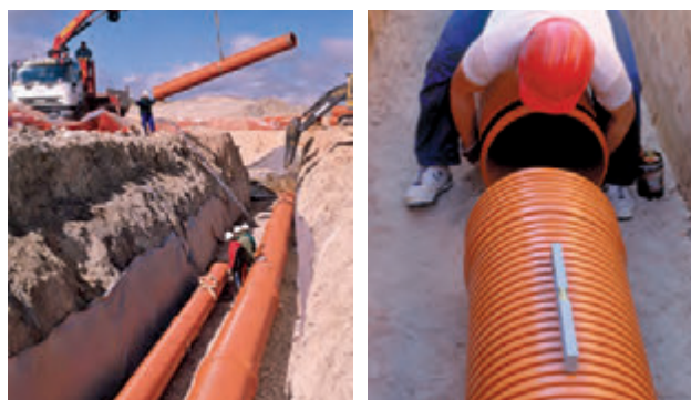
A LA IZDA., MONTAJE DE TUBERÍAS SANECOR® CON MEDIOS MECÁNICOS DISCRETOS (DIÁMETROS MEDIOS Y GRANDES). A LA DCHA., UNIÓN MANUAL (DIÁMETROS PEQUEÑOS).
