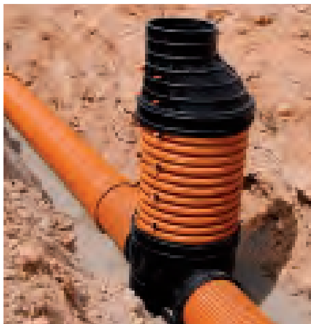
INSTALACIÓN DE PIEZA ENTRONQUE DE PASO TOTAL.
