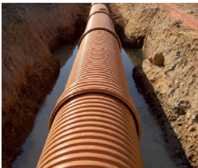
COLECTOR DE PVC CORRUGADO SN8.
