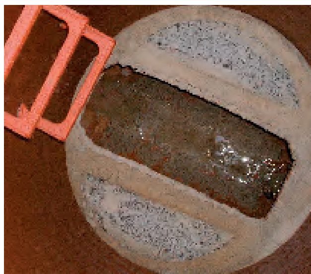
INTERIOR DEL POZO CON BASE ESTANCA.
