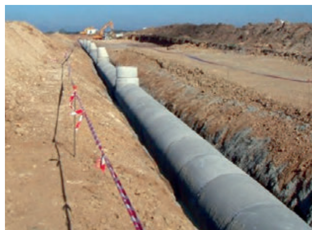
COLECTOR DE HORMIGÓN ARMADO.
