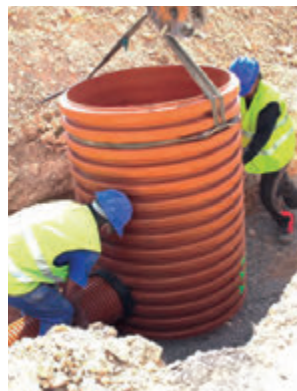
INSTALACIÓN DE TUBERÍAS AL CUERPO DEL POZO.
