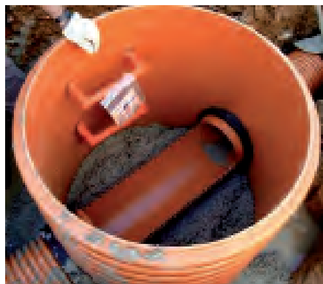
HORMIGONADO DEL FONDO DEL POZO. 2ª FASE.
