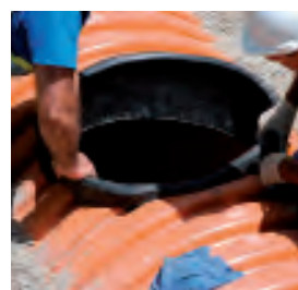
INSTALACIÓN DEL CUERPO CON BASE DE REGISTRO.
