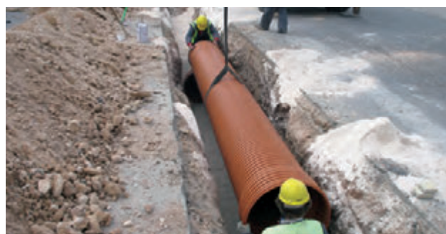
MANIPULACIÓN EN OBRA DEL TUBO SANECOR®.
