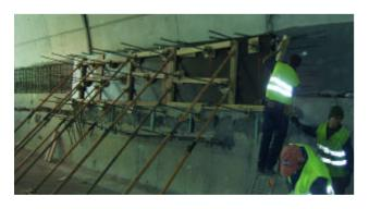
Reparación de las zonas repicadas de los muretes mediante la utilización de LEGARAN PISTOLA y EMACO S88 TIXOTRÓPICO.
