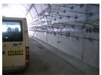
9. Tesado del acero a 200-210 kN, con gatos hidráulicos accionados manualmente.
