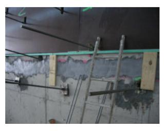
8. Colocación y anclaje con **CONCRESIVE 4000** del acero a tesar. La resina se coloca exclusivamente en la zona correspondiente a la sección original del túnel, inyectándola a través de tubos de plástico hasta el fondo del taladro con el fin de asegurar el completo llenado en la zona correspondiente a la sección del túnel original, de tal forma que el acero quede libre en la zona del murete.
