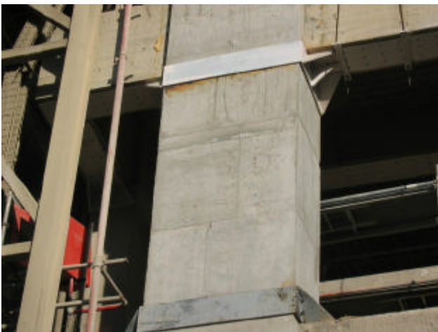
Fotografía núm. 10. Aspecto final del recrecido.
