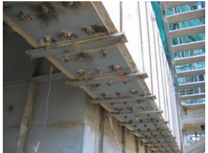
Fotografía núm. 11. Instalación de las pletinas.
