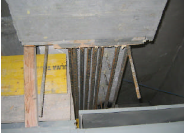
Fotografía núm. 3. Instalación de nuevas armaduras.
