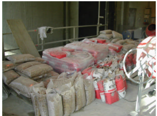
Fotografía núm. 6. Acopio del material próximo a la zona de amasado.
