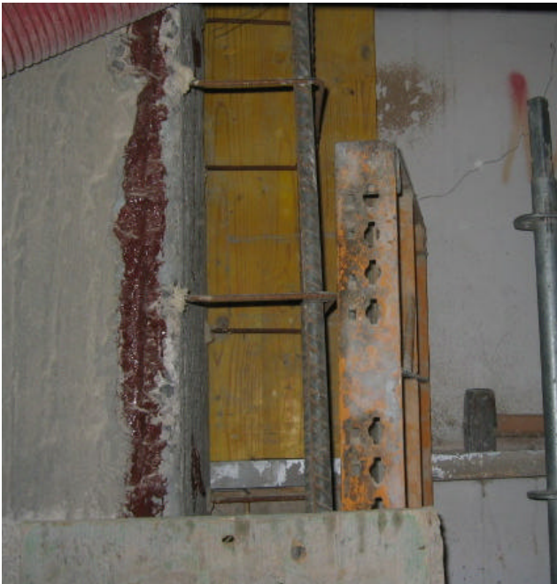
Fotografía núm. 4. Pasivación de las armaduras descubiertas e instalación de las nuevas armaduras.
