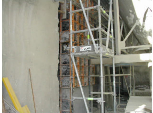
Fotografía núm. 5. Montaje de encofrados.
