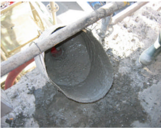
Fotografía núm. 9. Embudo preparado para facilitar el relleno del encofrado.
