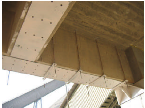
Fotografía núm. 11. Instalación de las pletinas.
