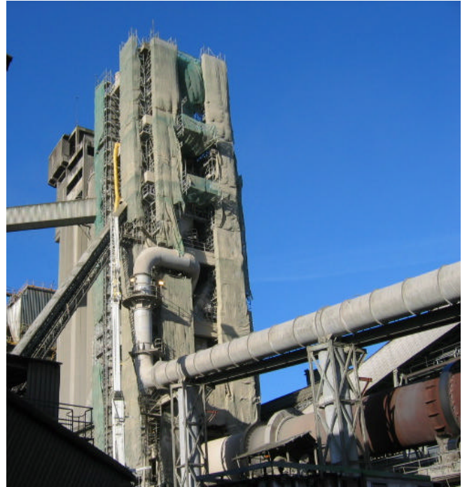
Fotografía núm. 1. Vista de la torre a reforzar.
