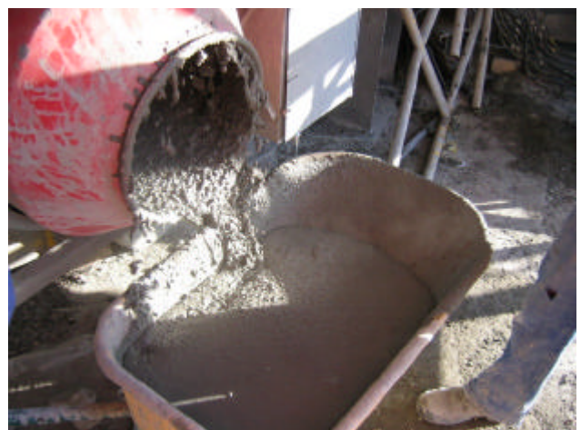
Fotografía núm. 7. Amasado del MASTERFLOW 928 y el GROUT FILLER.
