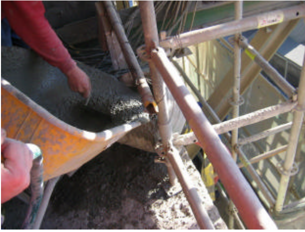
Fotografía núm. 8. Relleno encofrado.
