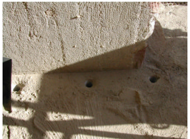
Fotografía núm. 2. Taladros para las nuevas armaduras.
