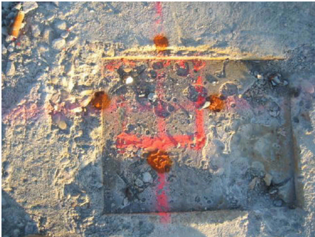
Estado inicial del soporte sin la preparación previa. Replanteo de los nuevos taladros.
