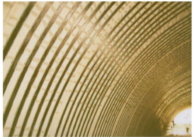
**Fig nº8-** Vista general del refuerzo ejecutado en todas las dovelas críticas. La excelente durabilidad de los compuestos de fibra de carbono permiten un contacto directo con condiciones adversas ambientales. Sin embargo, y a modo de protección de todo el paramento, se aplica un revestimiento anticarbonatación acrílico.
