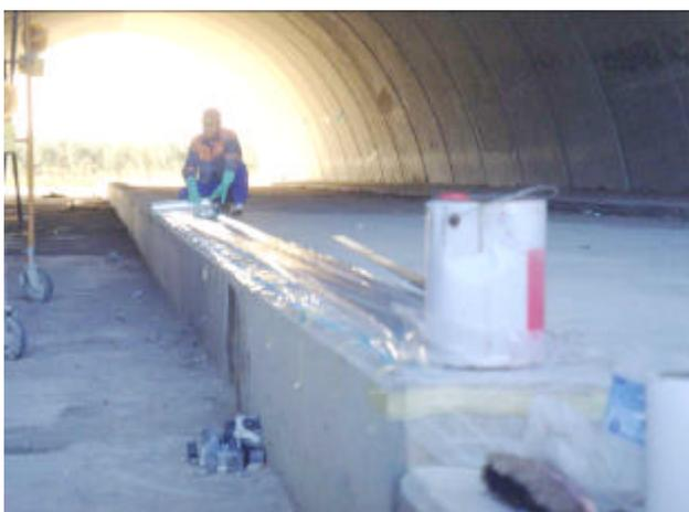
**Fig n°2.-** Detalle del proceso de limpieza del laminado LM 100/1.4 empleado así como su posterior aplicación del Adhesivo MBrace. Se aplican bandas de 8 m de longitud adheridas perfectamente al soporte, evitando soldaduras y uniones atornilladas.
