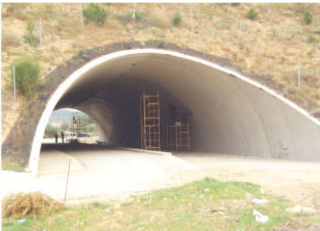
**Fig n°1.-** Vista general del paso subterráneo. La ligereza del sistema MBrace no precisa apuntalamiento, y los medios auxiliares de trabajo son muy ligeros. Esto permite no interferir en el tráfico de las vías secundarias usuarias del paso inferior.
