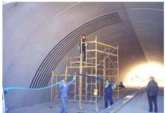
**Fig n°4.-** Cómoda puesta en obra de un LAMINADO LM 100/1.4. El refuerzo tradicional con platabanda metálica hubiera sido infinitamente más complejo, con soldaduras, formas curvas específicas preformadas y apuntalamiento pesado. La ligereza de las fibras y su gran calidad suponen una clara ventaja constructiva.
