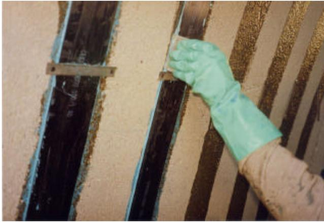
**Fig nº5.-** Detalle de limpieza de Adhesivo MBrace excedente, tras presionar fuertemente con rodillo de goma dura.
