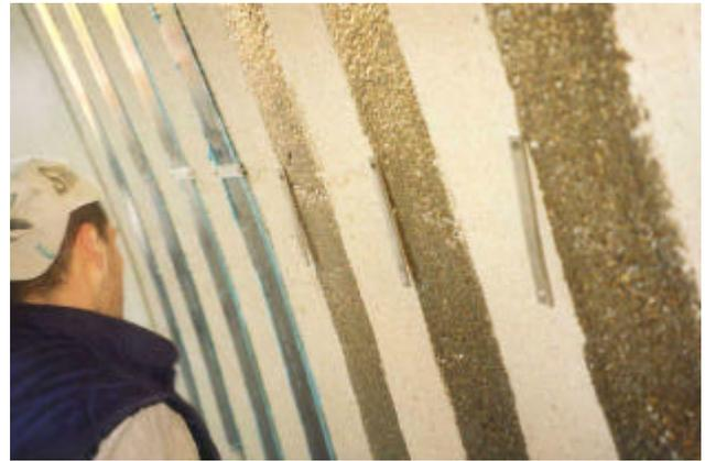
**Fig n°3.-** Las características de la obra permiten un tratamiento de soporte ideal: chorreo de arena. Se consigue un soporte uniforme y sin lechada. Para conseguir una perfecta adhesión a la forma curva de la dovela se emplea un ingenioso sistema de lámina atornillada a ambos lados.
