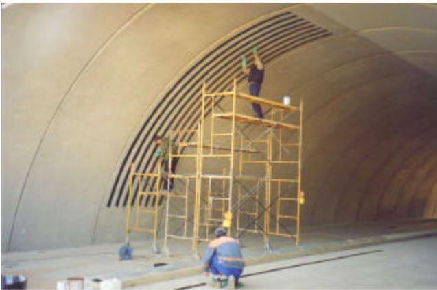
**Fig nº6-** Vista general del refuerzo de la primera dovela. Los medios auxiliares empleados muy ligeros y la rapidez de puesta en obra garantizan el sistema MBrace como una alternativa claramente competitiva.
