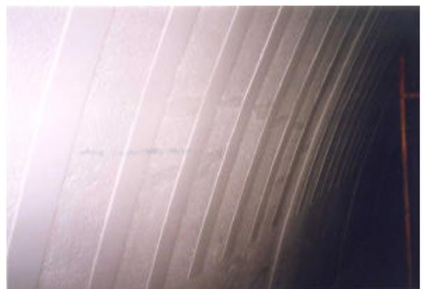
**Fig nº10.-** Detalle del revestimiento anticarbonatación POLYFLEX de acabado.
