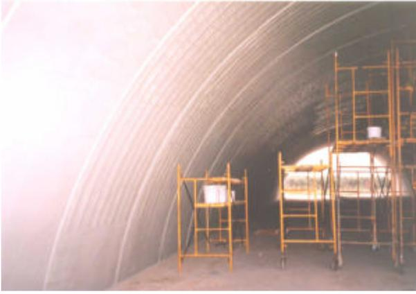
**Fig nº11.-** Vista de los medios auxiliares ligeros empleados durante todas las fases de la obra: preparación soporte, refuerzo y protección.
