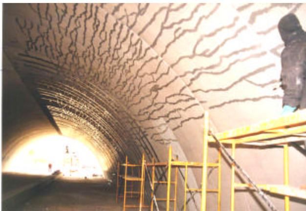
**Fig nº7-** Vista general de los trabajos de sellado de fisuras debidas al asentamiento diferencial de la cimentación. El sellado superficial mediante APOTEN FLEXIBLE garantiza la durabilidad de las estructura evitando la corrosión, y los compuestos de fibra de carbono cosen la fisuración colaborando estructuralmente con el acero de armado de cada dovela.
