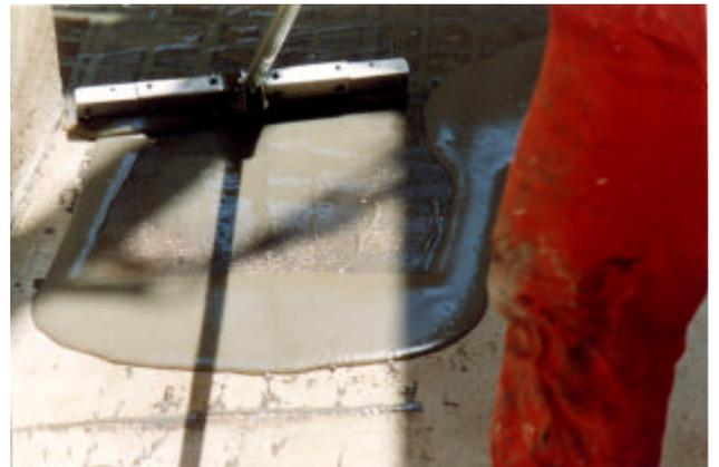
Foto 3: Aplicación de la imprimación CONIPOX 77Z.
