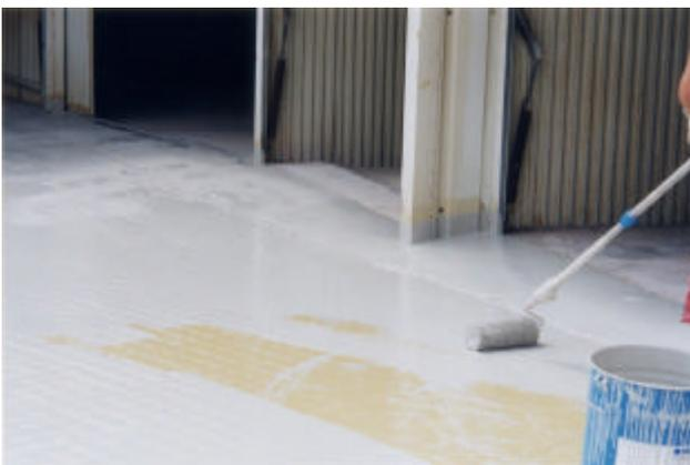
**Foto 7:** Aplicación del CONIPUR 267F.
