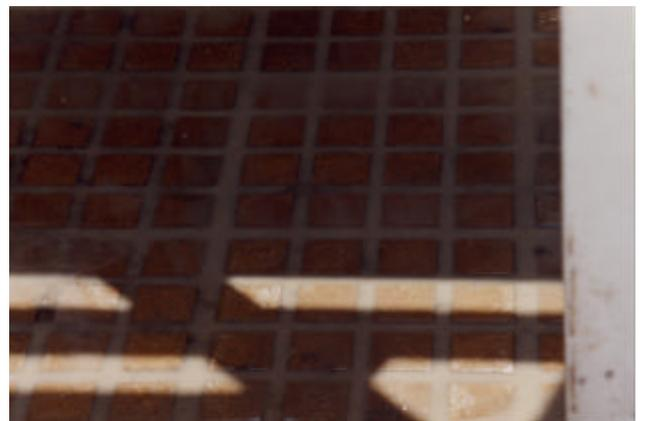
Foto 4: Estado del soporte tras la aplicación de la imprimación.
