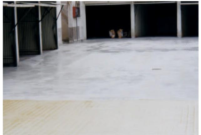
**Foto 9:** Aspecto de la capa de rodadura formada, se observa la diferencia entre la zona con la capa de rodadura ya formada de la zona en la que todavía no se ha aplicado.
