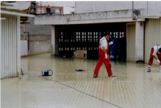
**Fotos 5 y 6:** Vista de la superficie después de aplicar la membrana.
