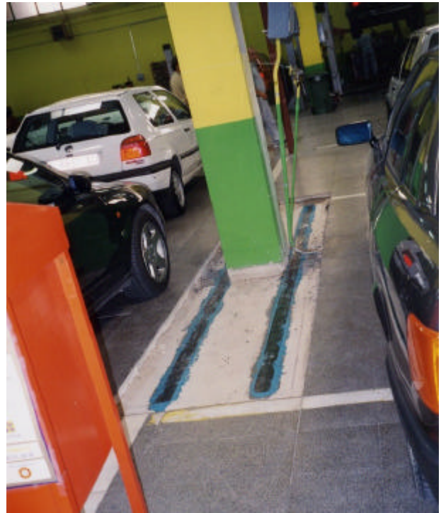
Foto 3.- Refuerzo a positivos de fácil ejecución.
