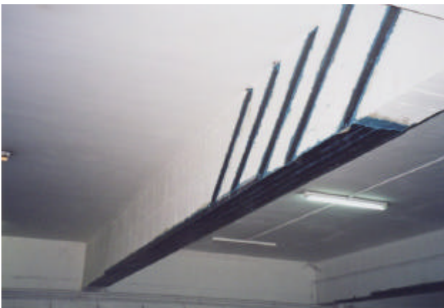
Foto 2.- Vista del refuerzo a flexión y a cortante.
