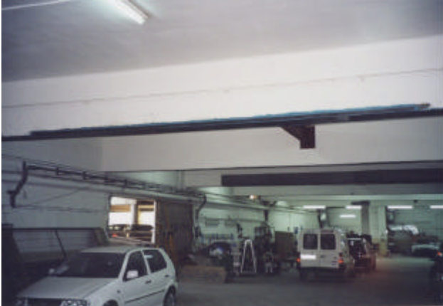
Foto 1.- Refuerzo sin interferir en el uso habitual del local.
