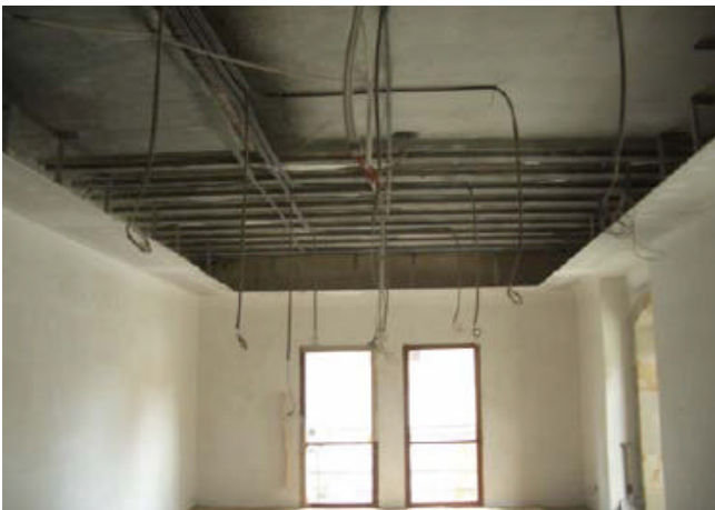
Ejemplos de las zonas donde se han realizado reparaciones
