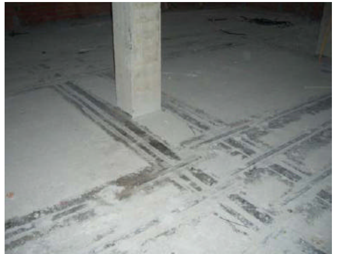
Ejemplos de refuerzo estructural, tanto a momentos positivos como negativos, mediante MBrace LAMINADO.
