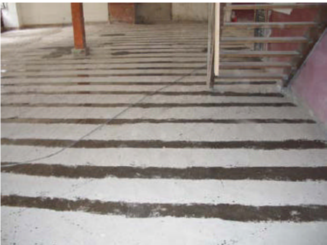
Imprimación con MBrace Resin 50 (MBrace IMPRIMACIÓN)
