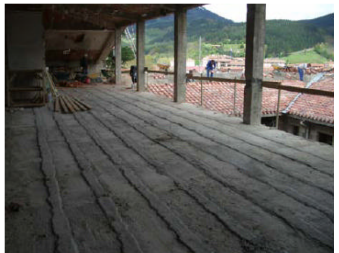
Ejemplos de refuerzo estructural, tanto a momentos positivos como negativos, mediante MBrace LAMINADO.
