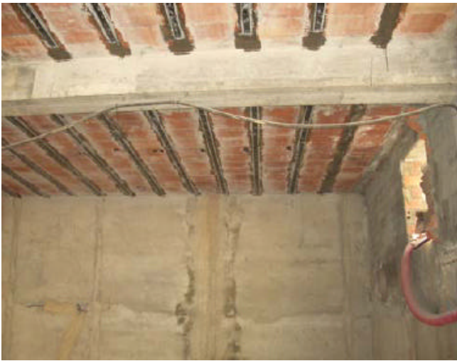
Ejemplos de refuerzo estructural, tanto a momentos positivos como negativos, mediante MBrace LAMINADO.
