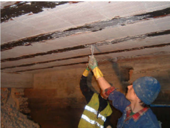
Aplicación del adhesivo con MBrace Resin 220 (Mbrace ADHESIVO)
