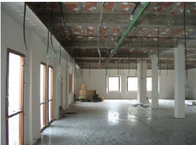
Protección del MBrace LAMINADO con mortero para evitar daños durante la obra.
