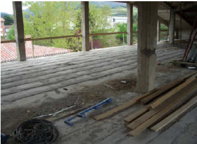
Protección del MBrace LAMINADO con mortero para evitar daños durante la obra.
