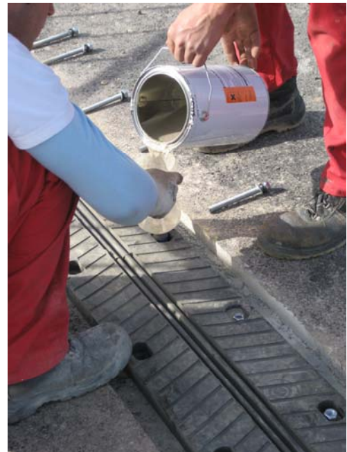
Colocación de la junta AGWJ 70 y anclaje de pernos (MASTERFLOW 920 – MASTERFLOW 140)
