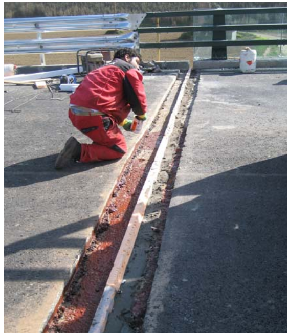
Aplicación del Puente de Unión con EMACO Epoxiprimer BP
