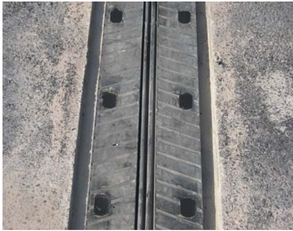
Relleno de Agujeros de Anclaje MASTERFLEX 476
