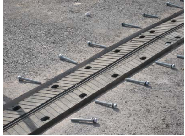
Pernos de anclaje Junta AGWJ 70
