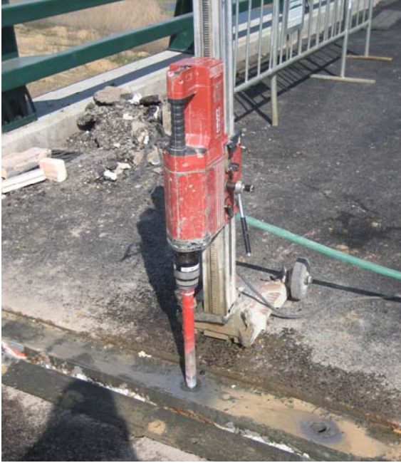
Taladro de agujeros para pernos de anclaje
