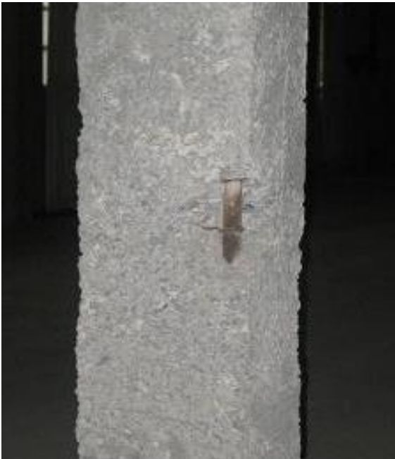
Estado inicial de la estructura.
