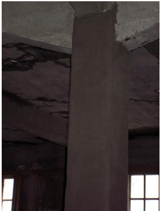
Pilar reconstruido con Emaco NANOCRETE R4
