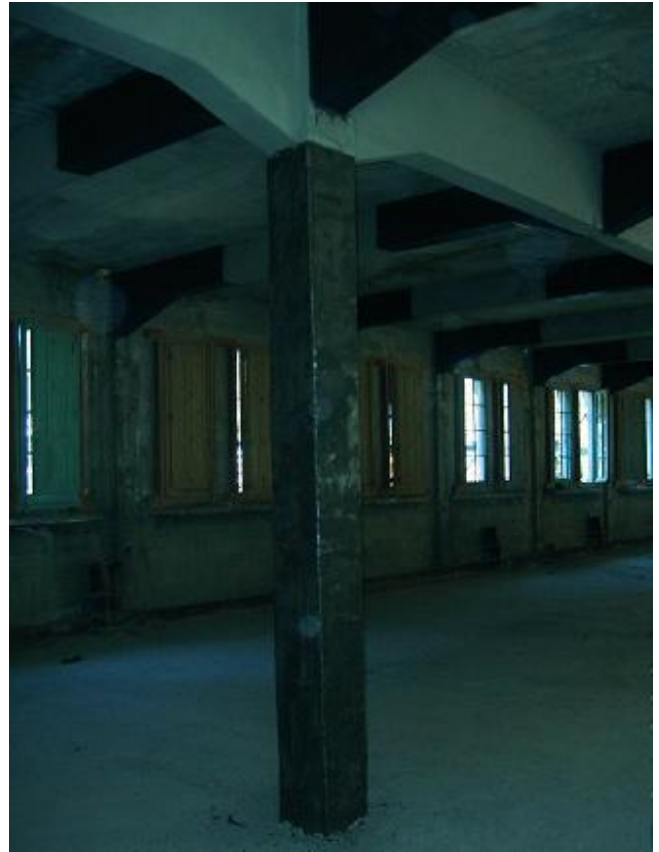
MBrace PRIMER sobre soporte de pilar
