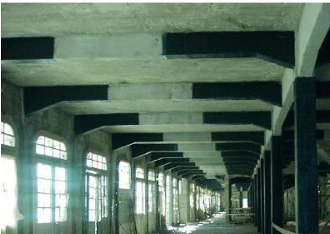
Vista general del refuerzo.
