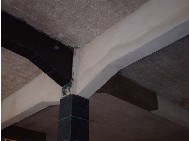
Refuerzo de jácenas frente esfuerzo cortante con Mbrace HOJA de FIBRA
