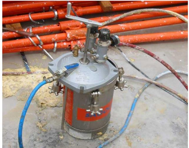
Verter el MasterInject 1325 Parte B al MasterInject 1325 Parte A y mezclar homogéneamente.
