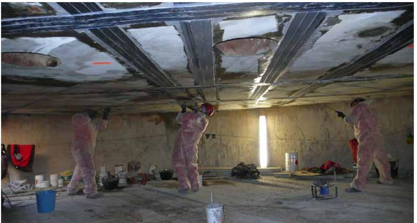
Los sistemas con laminados de fibra de carbono se aplican principalmente para refuerzos a flexión de vigas, losas y pilares.
