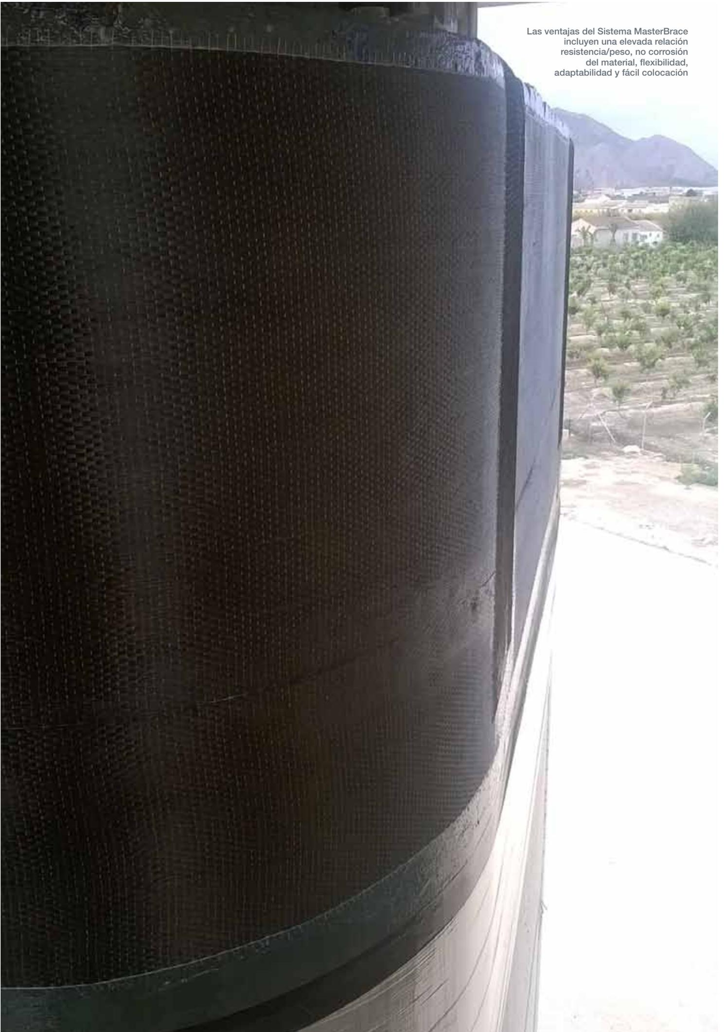
Refuerzo estructural mediante aplicación de laminado de fibra de carbono MasterBrace LAM
