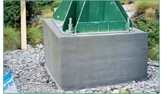
Zapatas sobre las que se anclan las torres de los telesillas antes de su reparación
