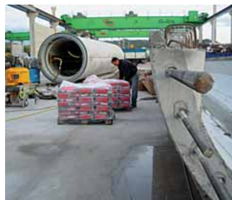
Anclaje de aerogeneradores con MASTERFLOW®
