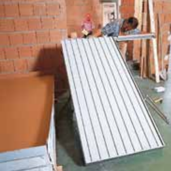
1. Introducir el travesaño superior en el encaste del armazón metálico.
