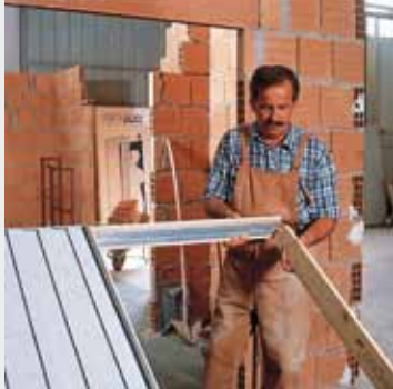
2. Introducir el montante en el travesaño superior y atornillarlo con dos tornillos suministrados.
