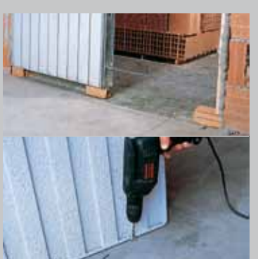
5a. Fijación sobre pavimento por terminar. 5b. Fijación sobre un pavimento terminado.
