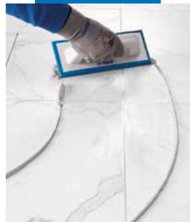
Aplicación de Ultracolor Plus en pavimento con lana de goma sobre baldosas de gres porcelánico efecto mármol
