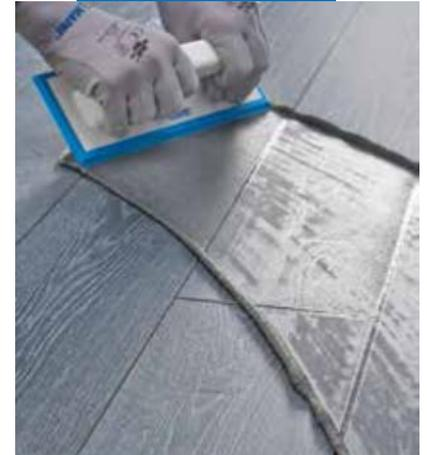
**Aplicación de Ultracolor Plus en pavimento con llana de goma, sobre baldosas de gres porcelánico efecto madera**
