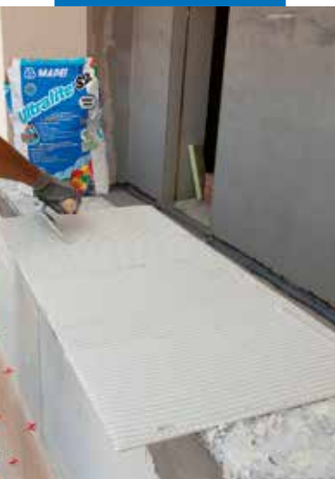
Extensión del adhesivo sobre el reverso de la baldosa
