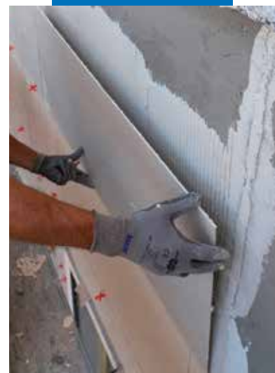
Aplicación de la baldosa de gres porcelánico de bajo espesor sobre fachada exterior
