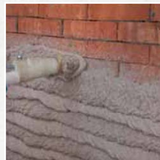
Aplicación por proyección de Planitop HDM Restauro sobre una pared de albañilería
