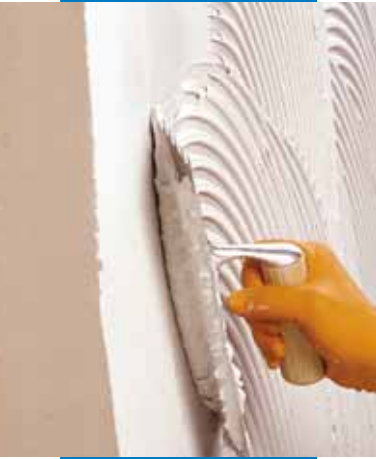
Aplicación de Tixobond White sobre soporte
