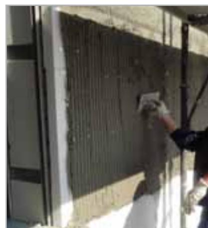
Fig. 5.9 – Extensión mediante llana metálica
