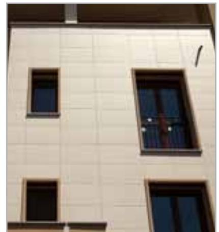
Fig. 3.2 - Edificio residencial revestido con MAPETHERM TILE SYSTEM
