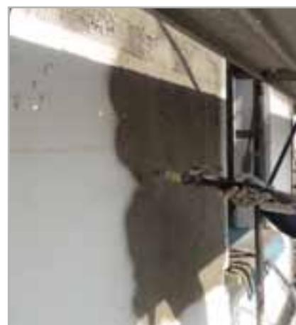
Fig. 5.8 – Aplicación de PLANITOP HDM MAXI a máquina
