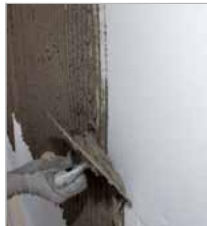
Fig. 5.7 – Aplicación de PLANITOP HDM MAXI sobre la superficie de los paneles de EPS
