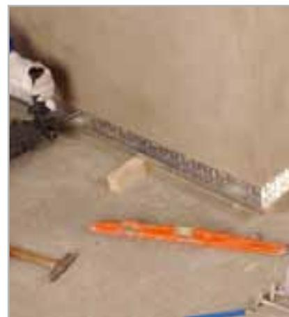
Fig. 4.16 - Posicionamiento de los perfiles MAPETHERM BA
