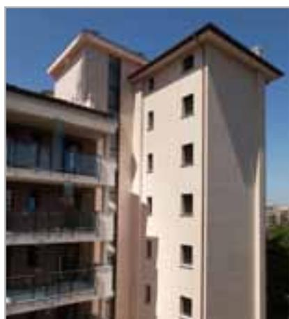
Fig. 1.3 - Edificio residencial revestido con MAPETHERM TILE SYSTEM
