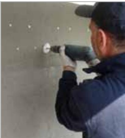
Fig. 5.12 - Aplicación de MAPETHERM TILE FIX 15
