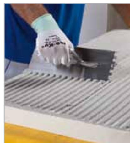
Fig. 5.3 – Aplicación del adhesivo sobre el dorso del panel
