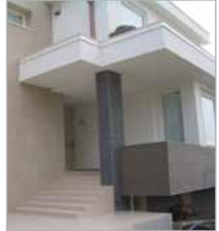
Fig. 3.1 - Edificio residencial revestido con MAPETHERM TILE SYSTEM
