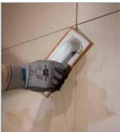
Fig. 5.19 – Rejuntado con ULTRACOLOR PLUS
