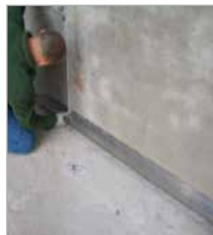
Fig. 5.2 - Colocación del perfil de partida MAPETHERM BA
