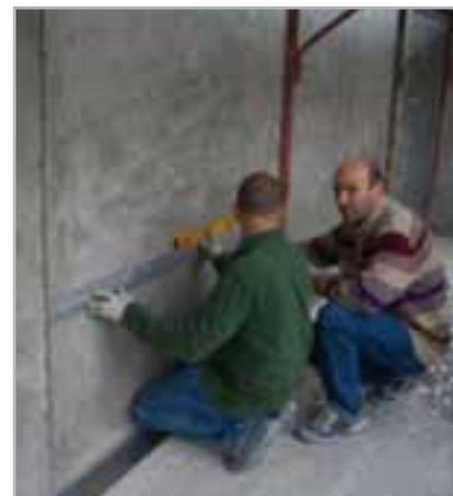
Fig. 5.1 – Verificación de la planitud del soporte
