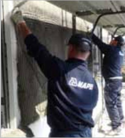
Fig. 5.10 - Colocación de la armadura MAPEGRID G 120
