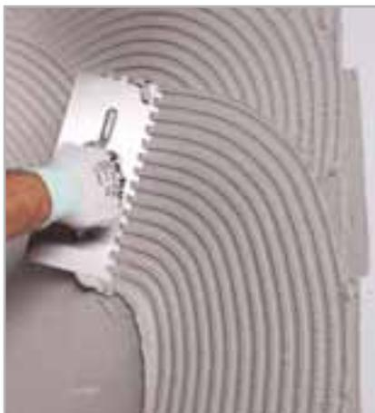
Fig. 5.4 – Aplicación del adhesivo sobre el soporte
