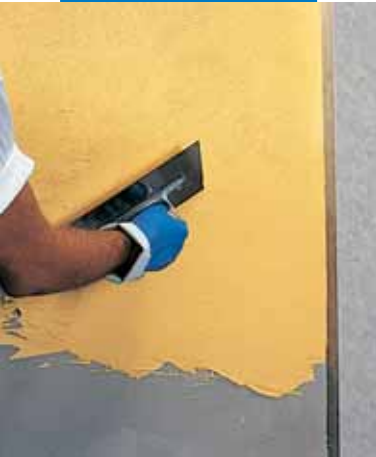
Aplicación de Silexcolor Tonachino con llana
