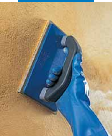
Acabado de Silexcolor Tonachino con fratás de esponja
