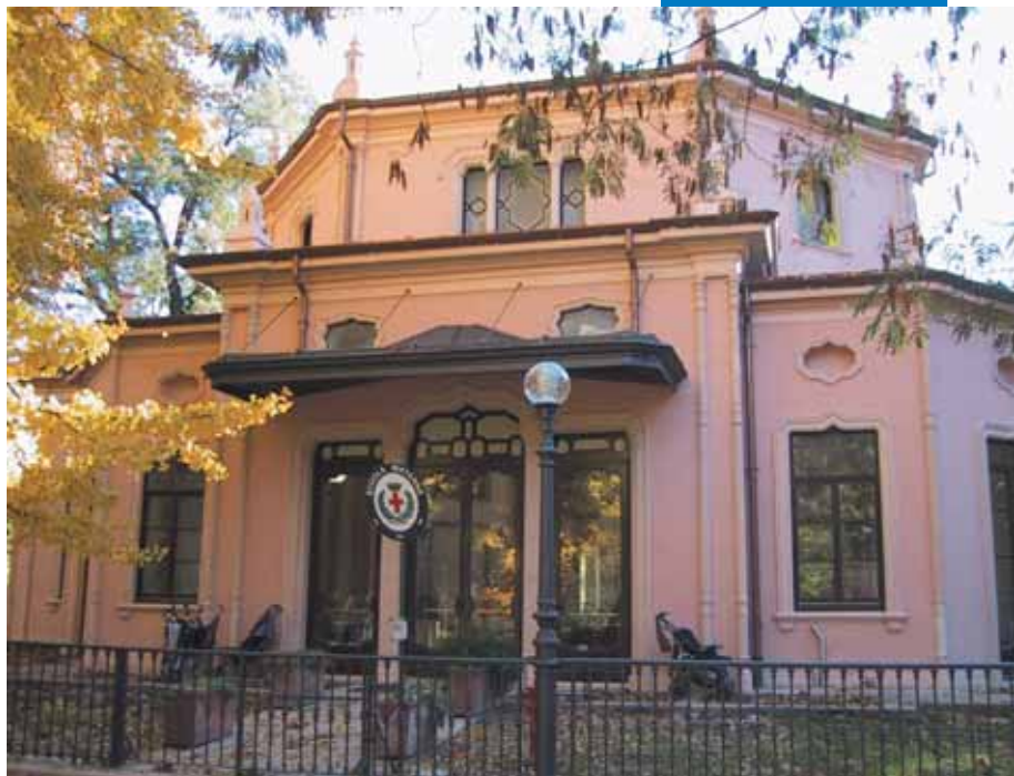
Ejemplo de aplicación de Silexcolor Tonachino. Guardería Giardini Porta Venezia (Milano) - Italia
